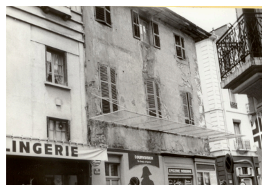
Façade sur la rue Despine Repro. François Fouger IVR82_20057300963NUCB
