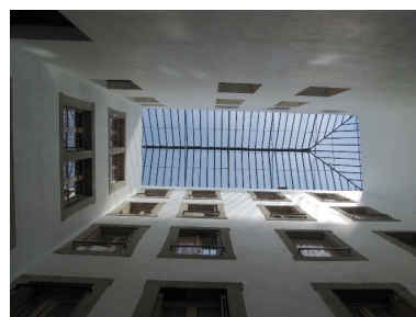
Verrière de la cour intérieure Phot. François Fouger IVR82_20067300412NUCA
