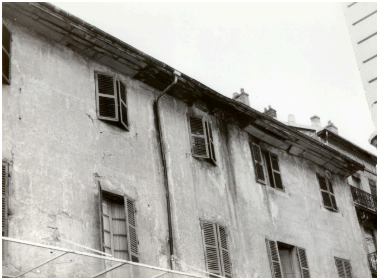
Partie supérieure de la façade rue du Casino
