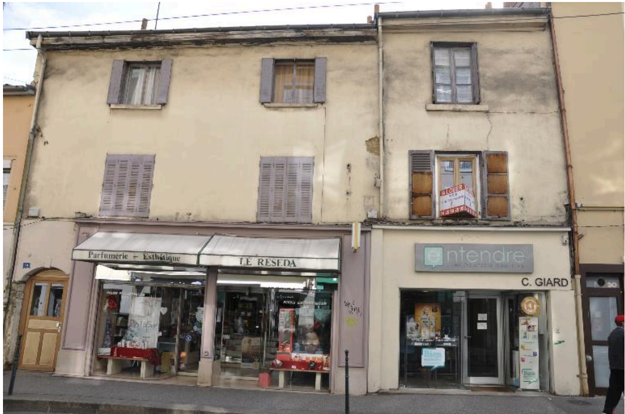
Vue d'ensemble ouest de l'immeuble d'une travée
