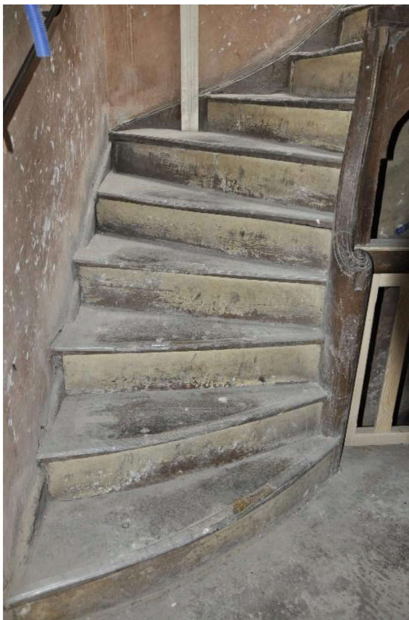
Vue de la seconde volée de l'escalier
