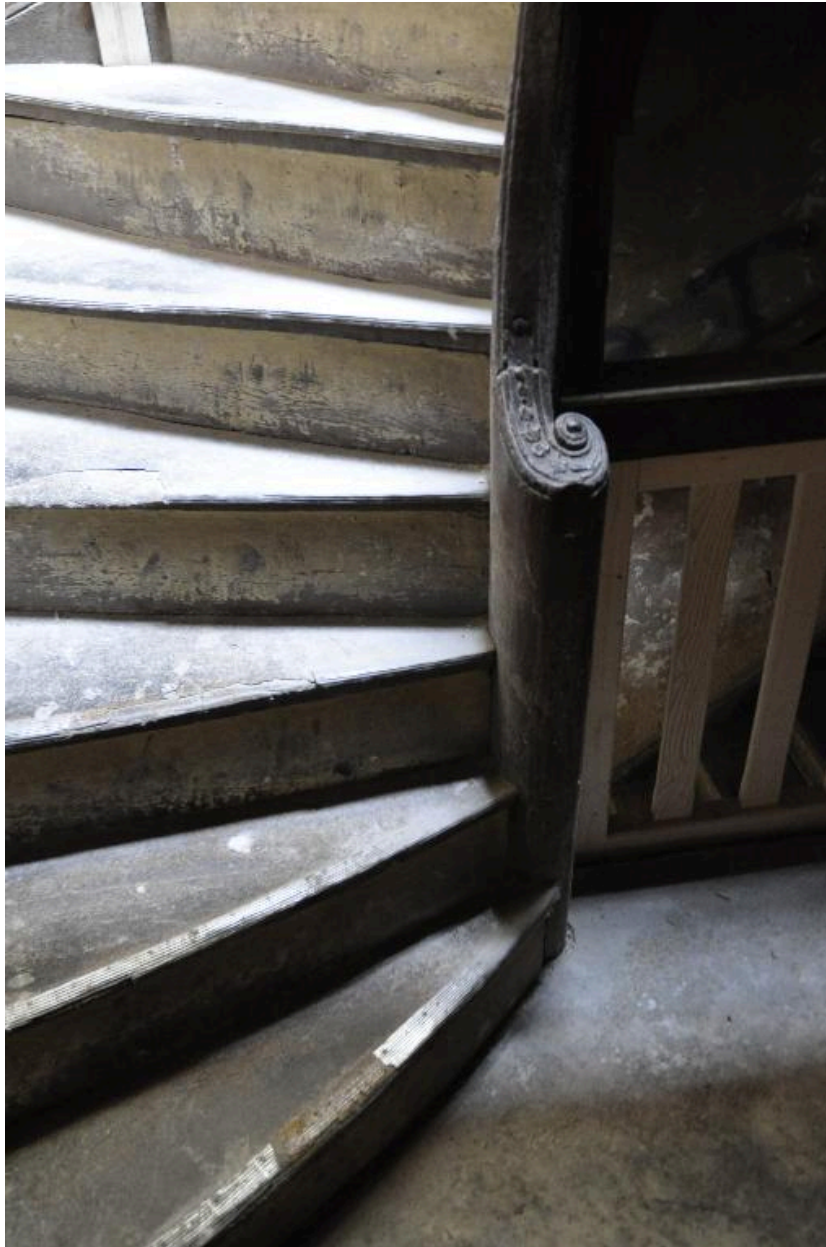
Vue de la rampe de l'escalier
