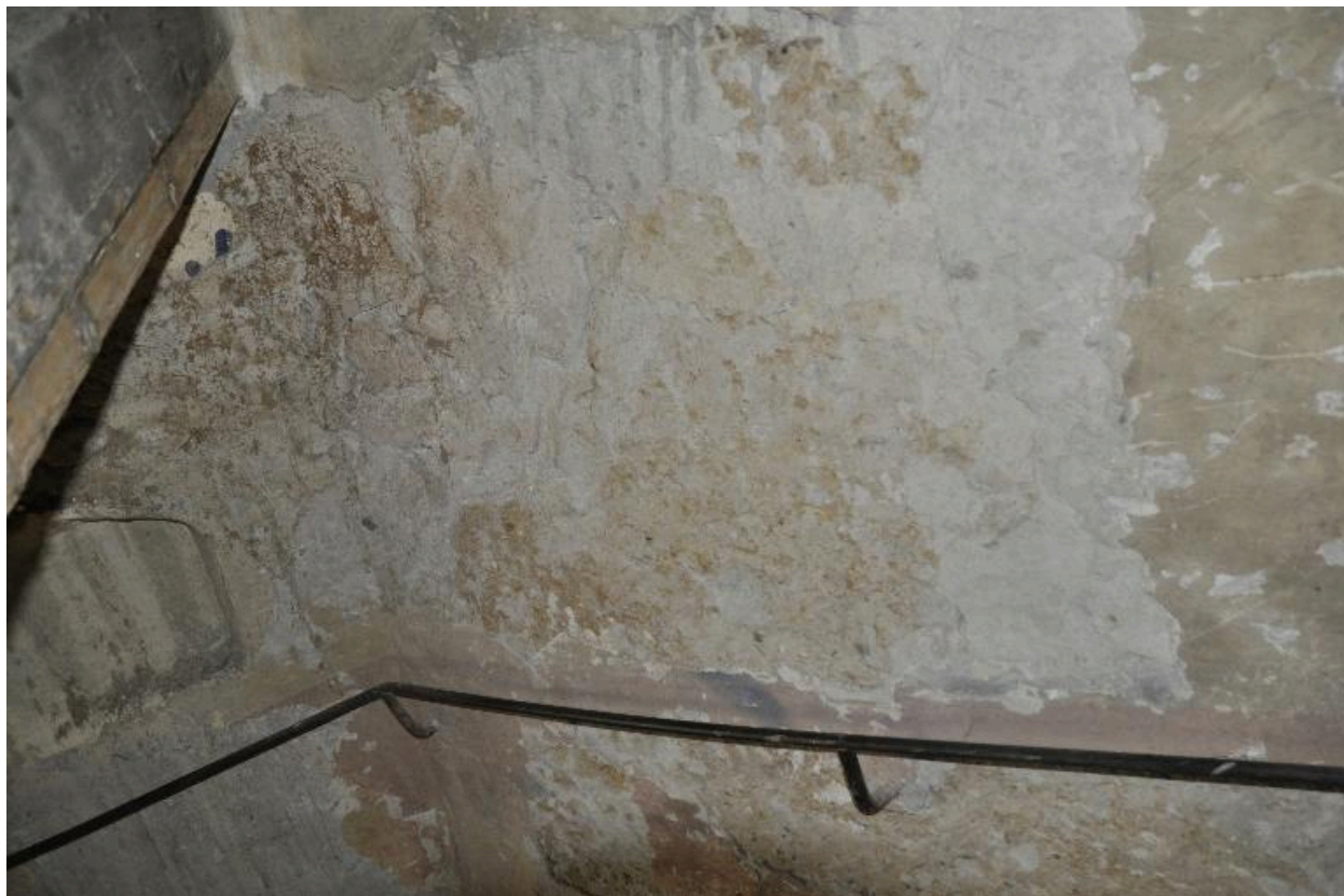
Détail du mur de la cage d'escalier
