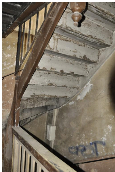
Vue de l'escalier depuis le palier Phot. Nadine Halitim-Dubois IVR82_20146900327NUCA
