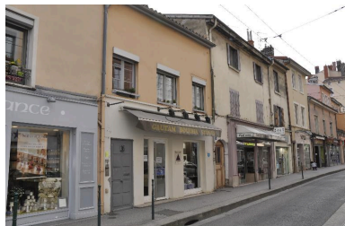
Vue d'ensemble nord ouest de l'immeuble de deux étages Phot. Nadine Halitim-Dubois IVR82_20146900321NUCA
