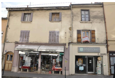
Vue d'ensemble ouest de l'immeuble d'une travée Phot. Nadine Halitim-Dubois IVR82_20146900520NUCA
