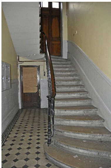
Vue intérieure : le départ de l'escalier Phot. Magali Delavenne IVR82_20146902918NUCA
