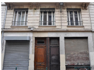
Vue rapprochée du rez-de-chaussée Phot. Magali Delavenne IVR82_20146902917NUCA
