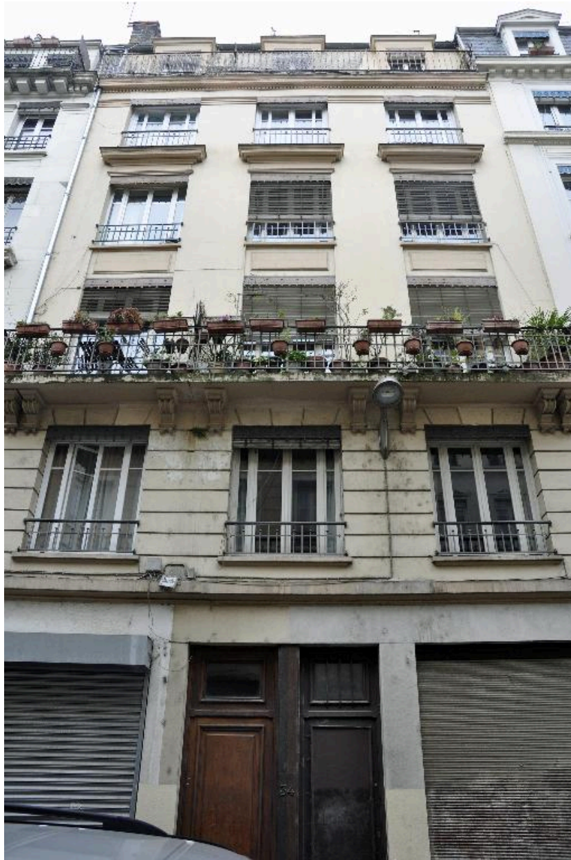
Vue générale de l'élévation sur rue
