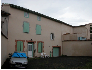
Vue générale. Phot. Thierry Monnet IVR82_20134200967NUCA
