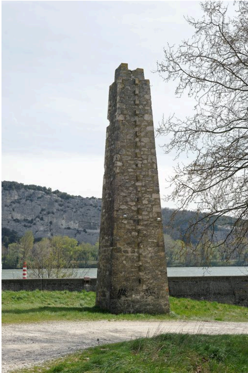
Pyramide de l'ancien bac, vue générale (face ouest)
