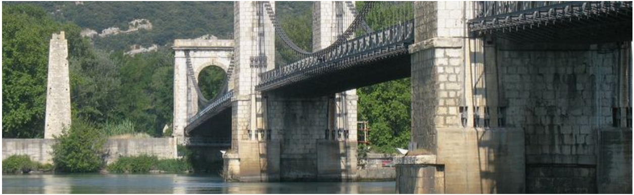
Vue panoramique, en amont du pont du Robinet (depuis la rive gauche)
