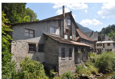
Vue générale du moulin, façade ouest Phot. Yannick Milleret IVR82_20107300631NUCA
