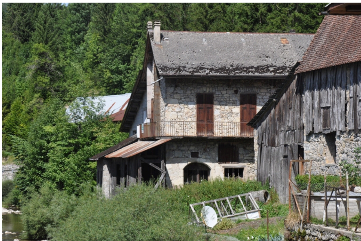
Vue de la façade sud
