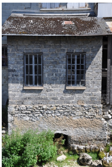
Détail du percement rectangulaire de la façade ouest Phot. Yannick Milleret IVR82_20107300633NUCA
