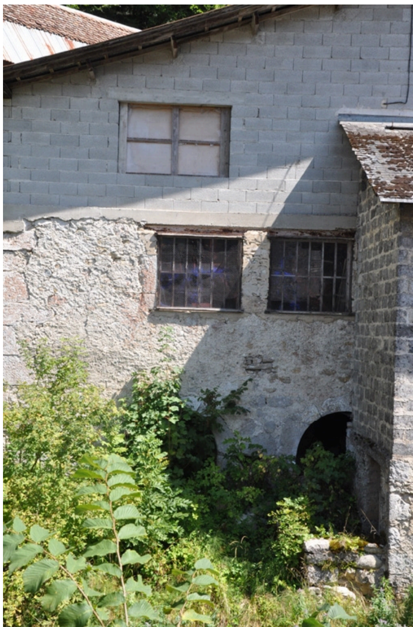
Détail des percements plein cintre de la façade ouest
