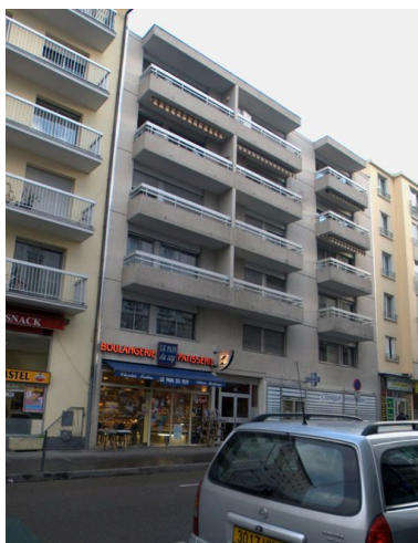
Elévation antérieure, depuis le sud-ouest Phot. Maryannick Chalabi IVR82_20116904085NUCA
