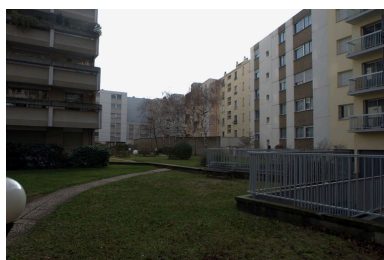
Elévation postérieure (la seconde en partant de la droite) Phot. Maryannick Chalabi IVR82_20116904112NUCA
