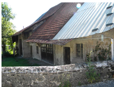
Vue de la façade sud- ouest de l'ensemble Phot. Jérôme Daviet IVR82_20137401005NUCA
