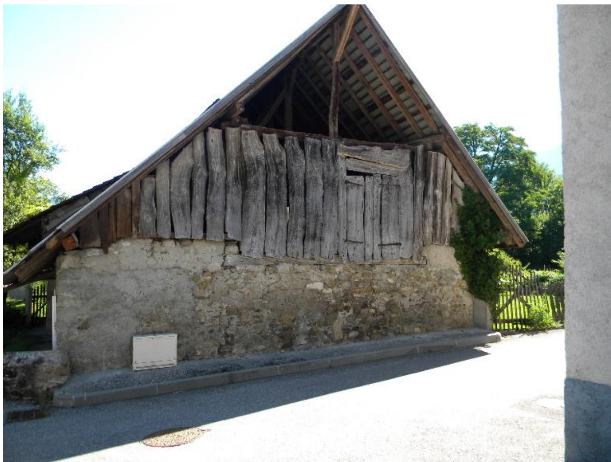
Vue du pignon nord-ouest
