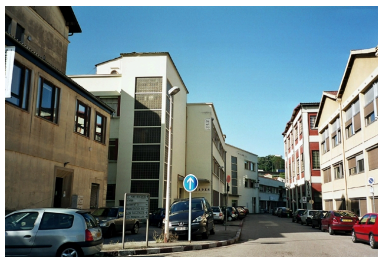
Vue d'ensemble des axes de circulation interne Phot. Nadine Halitim-Dubois IVR82_20046902934NUCA
