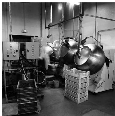
Chaudron-mélangeur Phot. Didier Gourbin IVR82_20036901744X
