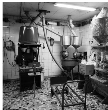
Salle des cafés : contrôle pesage Phot. Didier Gourbin IVR82_20036901769X
