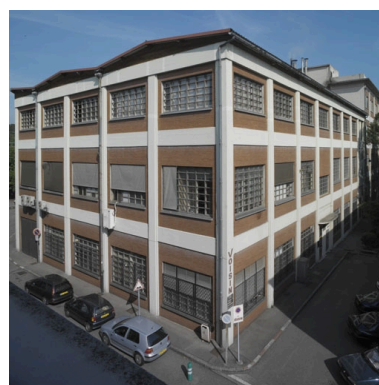
Vue générale, sud-ouest Phot. Eric Dessert IVR82_20036901638NUCA
