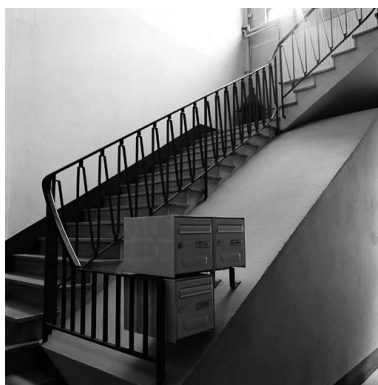
Escalier départ Phot. Didier Gourbin IVR82_20036901734X
