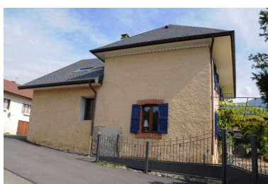
Vue de trois-quart depuis l'ouest, élévations latérales ouest Phot. Denys Harreau IVR82_20147301222NUCA
