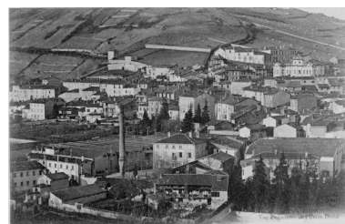
28.- BOËN - s - LIGNON / Vue d'ensemble de l'Usine David", vers 1900. Repro. Eric Dessert, Autr. Nancy (photographe) A. B. & Cie IVR82_20024200692XB
