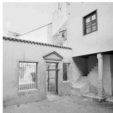
Vestiges du 2e corps de bâtiment sur cour. Phot. Didier Gourbin IVR82_20064200953X
