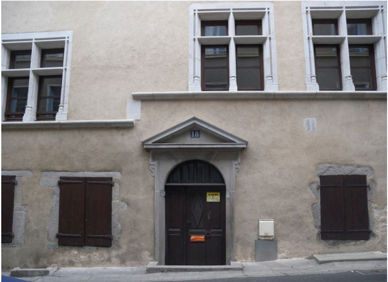
Détail, porte centrale surmontée d'un fronton triangulaire.
