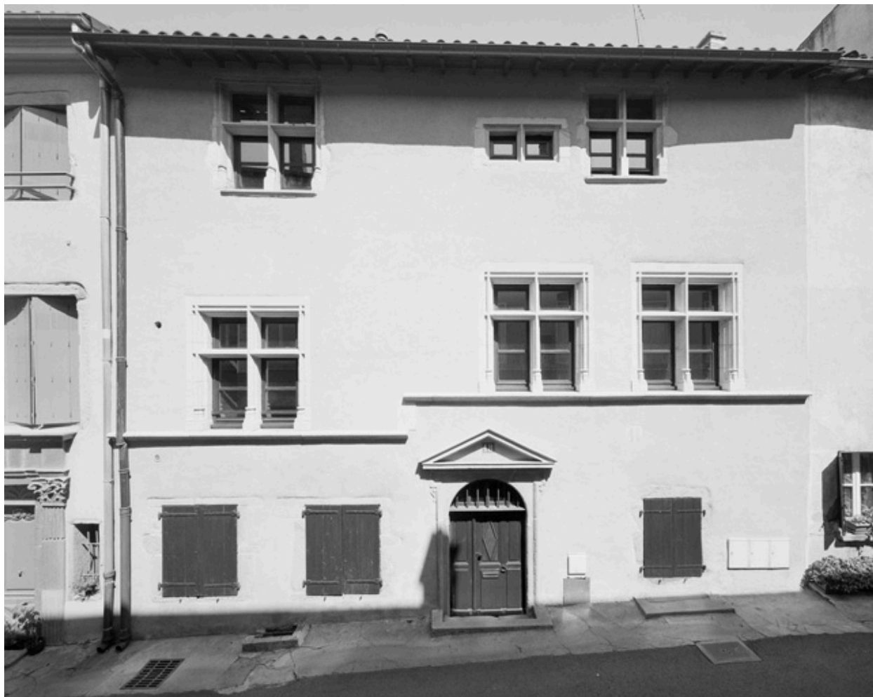
Vue générale, élévation sur rue.
