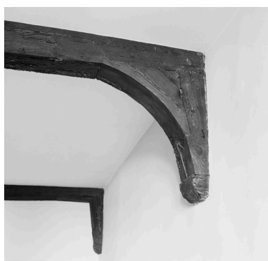
Vestiges des pièces de charpente qui soutiennent les poutres, au 1er étage. Phot. Didier Gourbin IVR82_20064200947X
