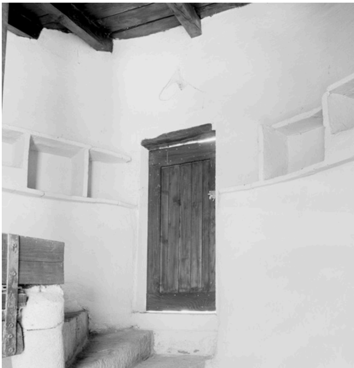
Nichoires du pigeonnier au sommet de la cage de l'escalier en vis.
