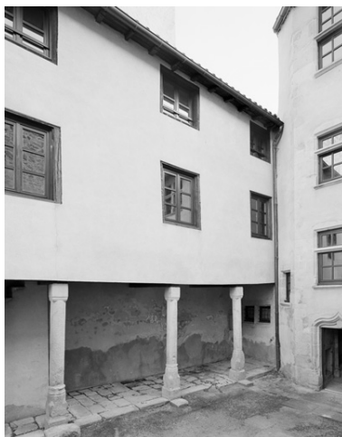
Galerie sur cour reliant les deux corps de bâtiments. Phot. Didier Gourbin IVR82_20064200989V
