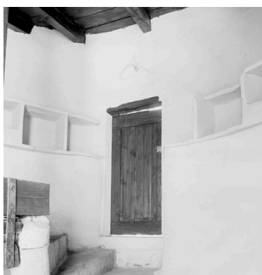
Nichoires du pigeonnier au sommet de la cage de l'escalier en vis. Phot. Didier Gourbin IVR82_20064200946X
