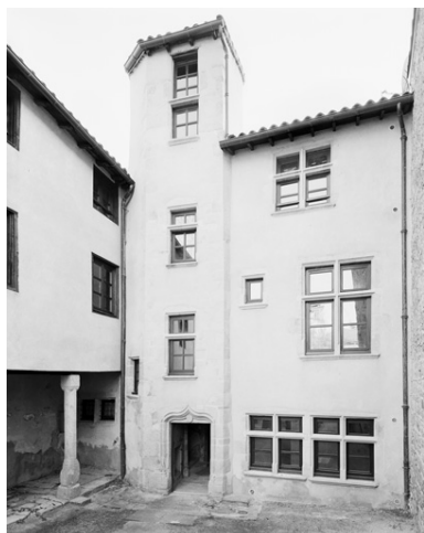
Cour intérieure, escalier en vis demi-hors-oeuvre. Phot. Didier Gourbin IVR82_20064200990V
