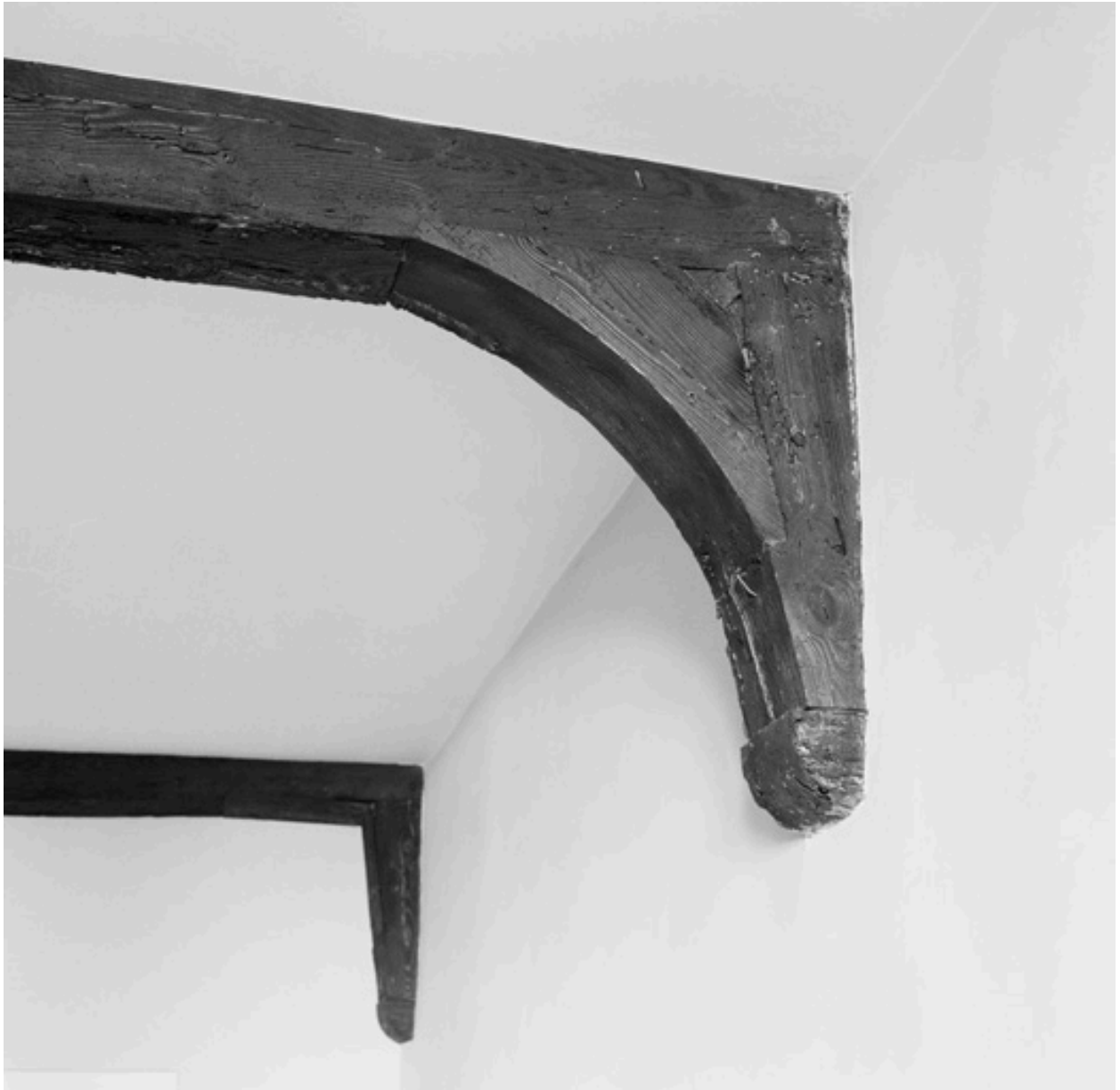
Vestiges des pièces de charpente qui soutiennent les poutres, au 1er étage.
