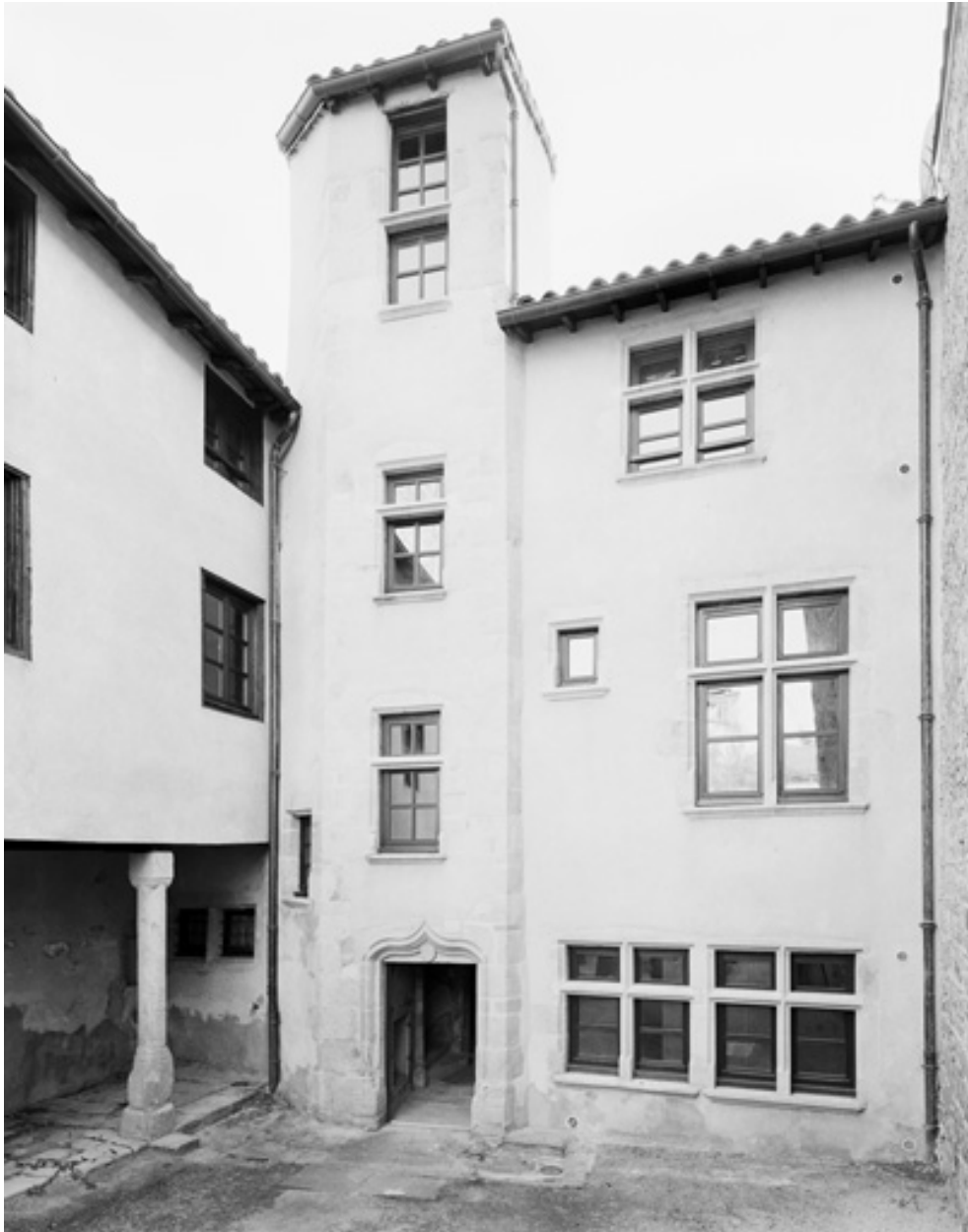
Cour intérieure, escalier en vis demi-hors-oeuvre.
