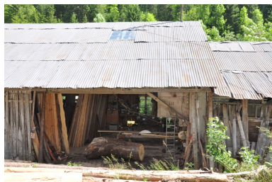
Vue générale de la scierie, façade nord Phot. Yannick Milleret IVR82_20107300623NUCA
