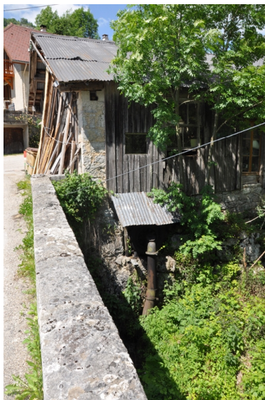
Vue de la scierie depuis le pont de la Fracette Phot. Yannick Milleret IVR82_20107300624NUCA
