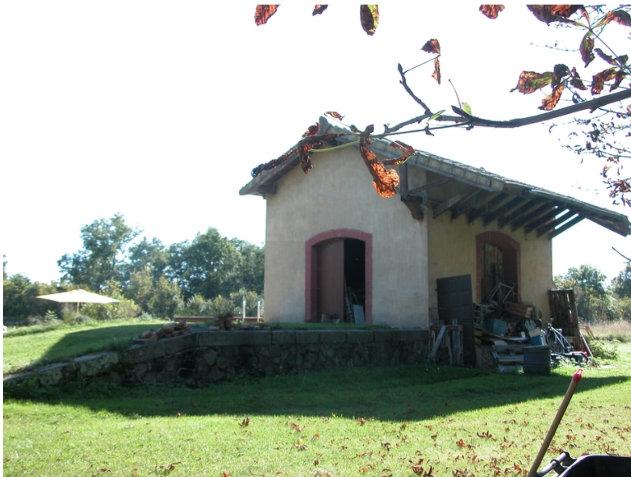
Vue d'ensemble du hangar de la gar (la Gare, 1986 A2 257).
