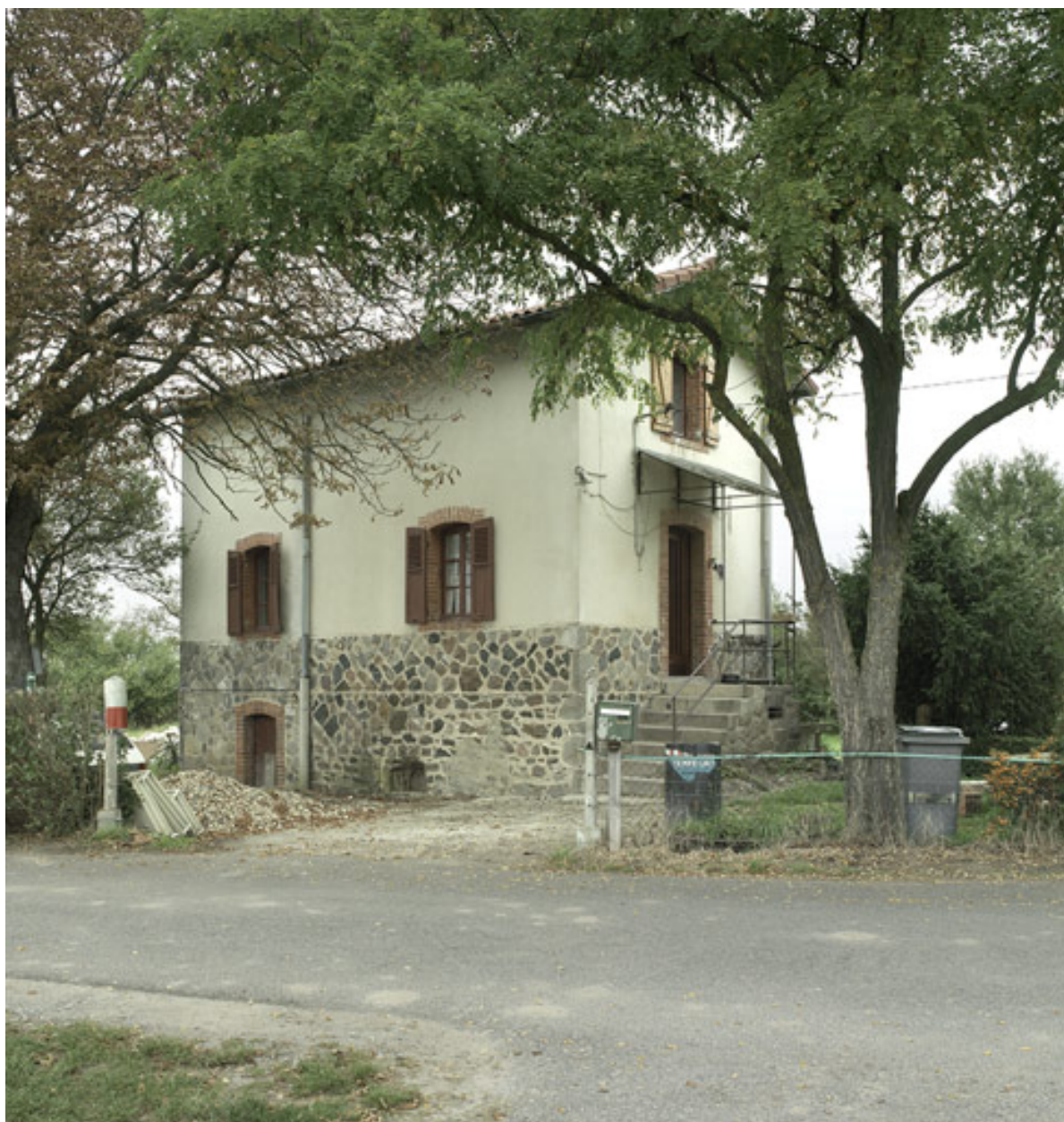
Vue d'ensemble de la maison de garde barrière de Champ de l'Orme (la Gare, 1986 A2 140).
