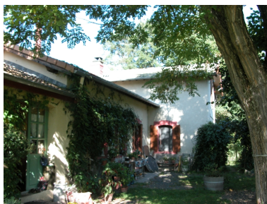
Vue d'ensemble de la gare (la Gare, 1986 A2 257).
