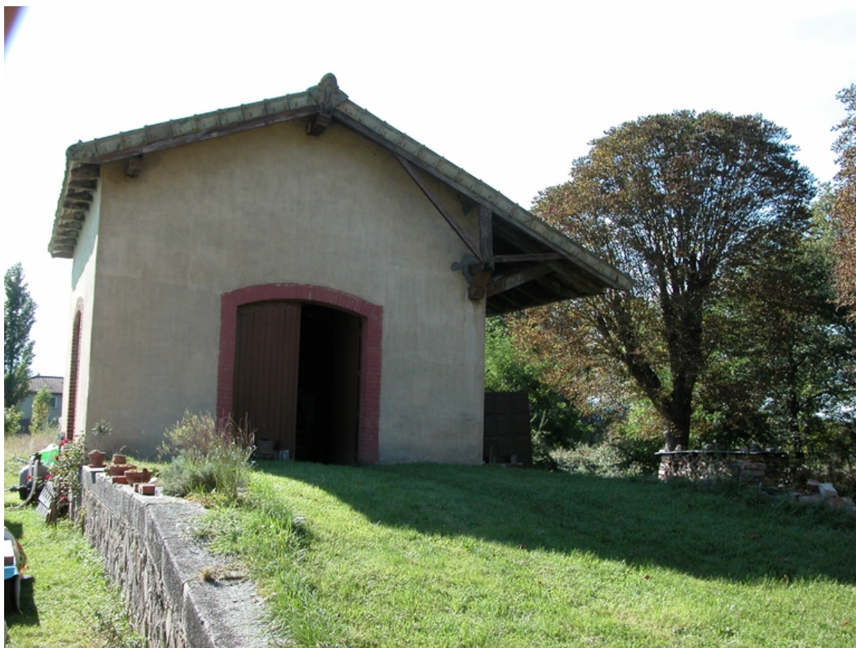
Vue du hangar de la gare (la Gare, 1986 A2 257).
