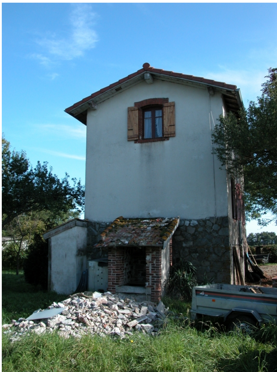
Vue de la maison de garde barrière de Champ de l'Orme (la Gare, 1986 A2 140).
