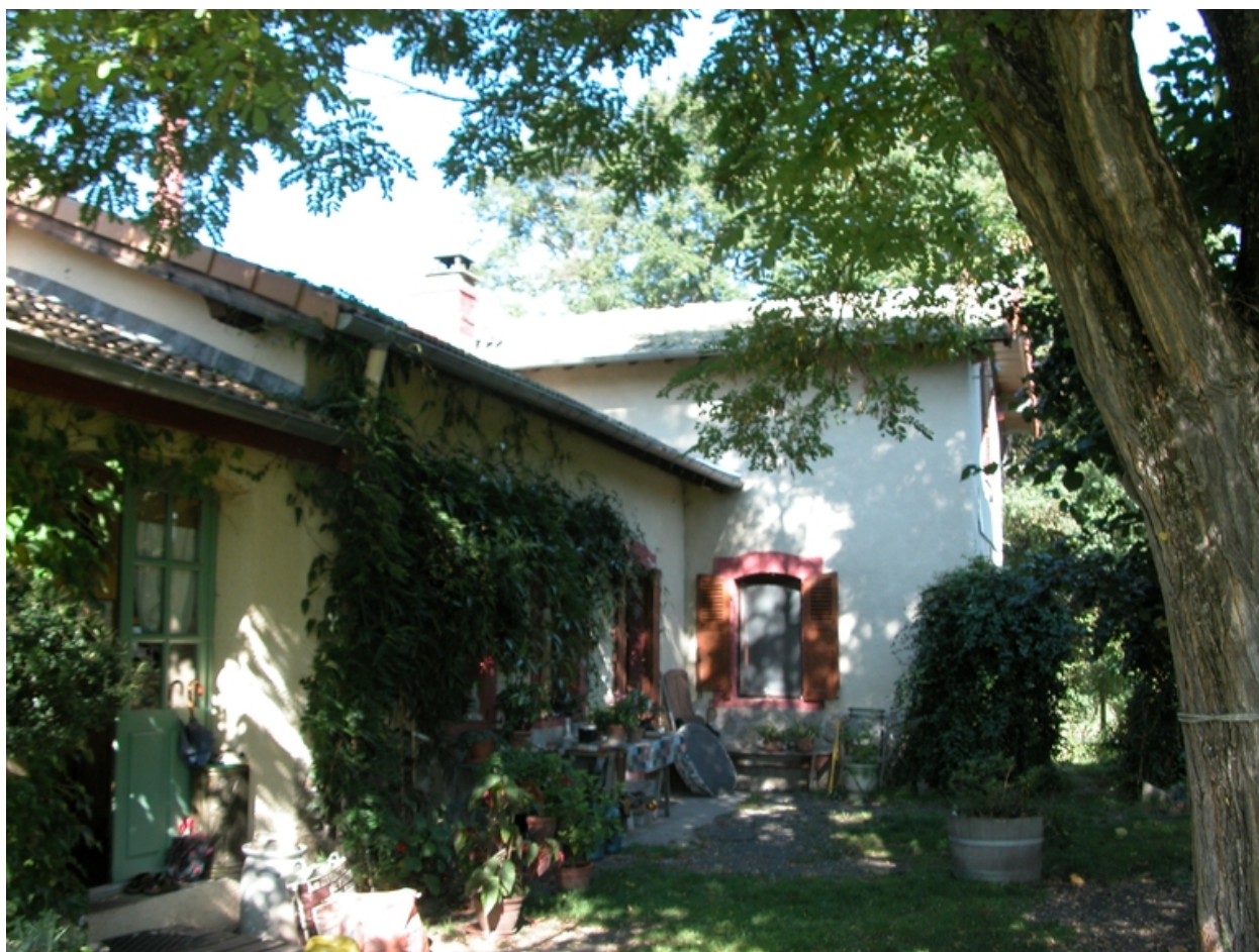
Vue d'ensemble de la gare (la Gare, 1986 A2 257).
