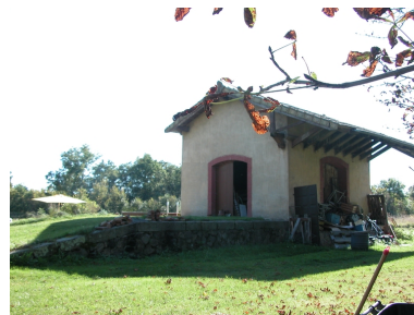
Vue d'ensemble du hangar de la gare (la Gare, 1986 A2 257).
