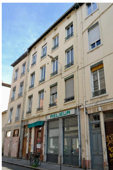
Vue générale, élévation sur rue Phot. Catherine Guégan IVR84_20176901354NUCA
