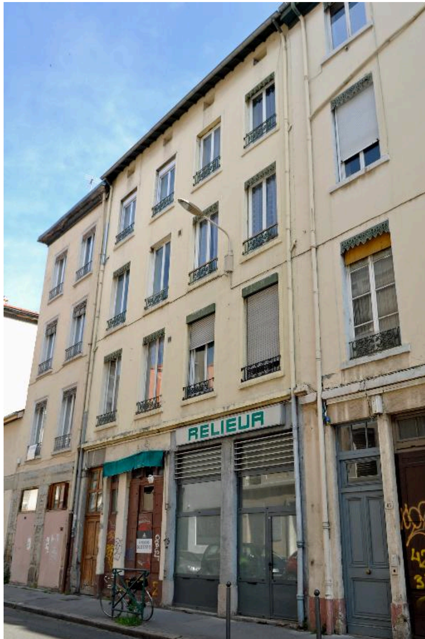
Vue générale, élévation sur rue
