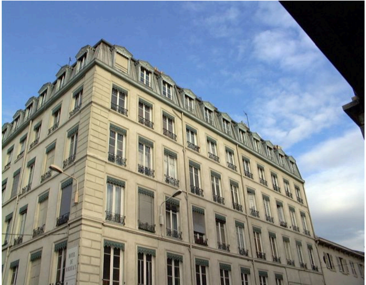
Elévation à l'angle des rues du Bélier et Delandine, les étages
