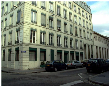
Elévation à l'angle des rues du Bélier et Delandine Phot. Bernard Ducouret IVR82_20006900655NUCA
