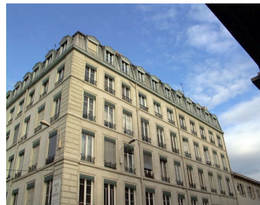
Elévation à l'angle des rues du Bélier et Delandine, les étages Phot. Bernard Ducouret IVR82_20006900657NUCA
