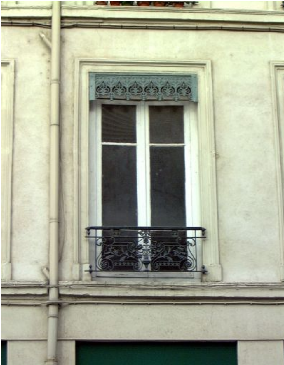
Détail d'une fenêtre rue Delandine
