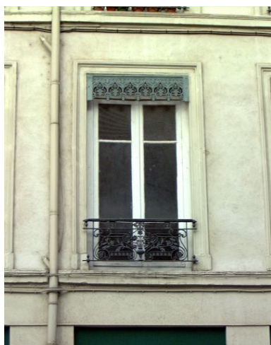
Détail d'une fenêtre rue Delandine Phot. Bernard Ducouret IVR82_20006900658NUCA
