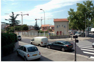
Vue de l'îlot 43 à 49 rue Edouard- Nieuport, 56 et 58 avenue Jean- Mermoz depuis le nord est Phot. Catherine Guégan IVR82_20076902225NUCA
