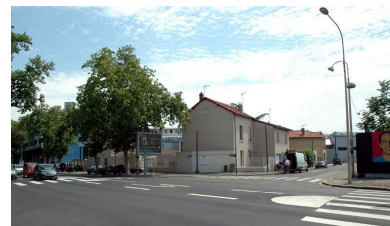
Vue de l'îlot 43 à 49 rue Edouard- Nieuport, 56 et 58 avenue Jean- Mermoz depuis le nord ouest Phot. Catherine Guégan
