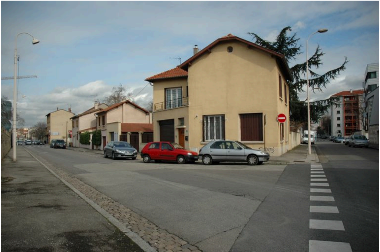
Vue des n° 43 à 49 rue Edouard-Nieuport depuis le sud
