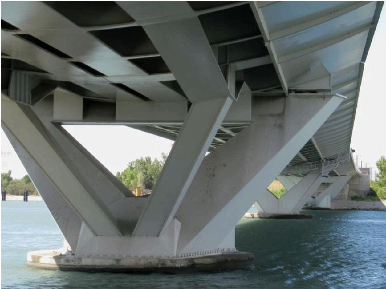
Pile gauche, de côté, face amont, vue générale (depuis la rive gauche)
