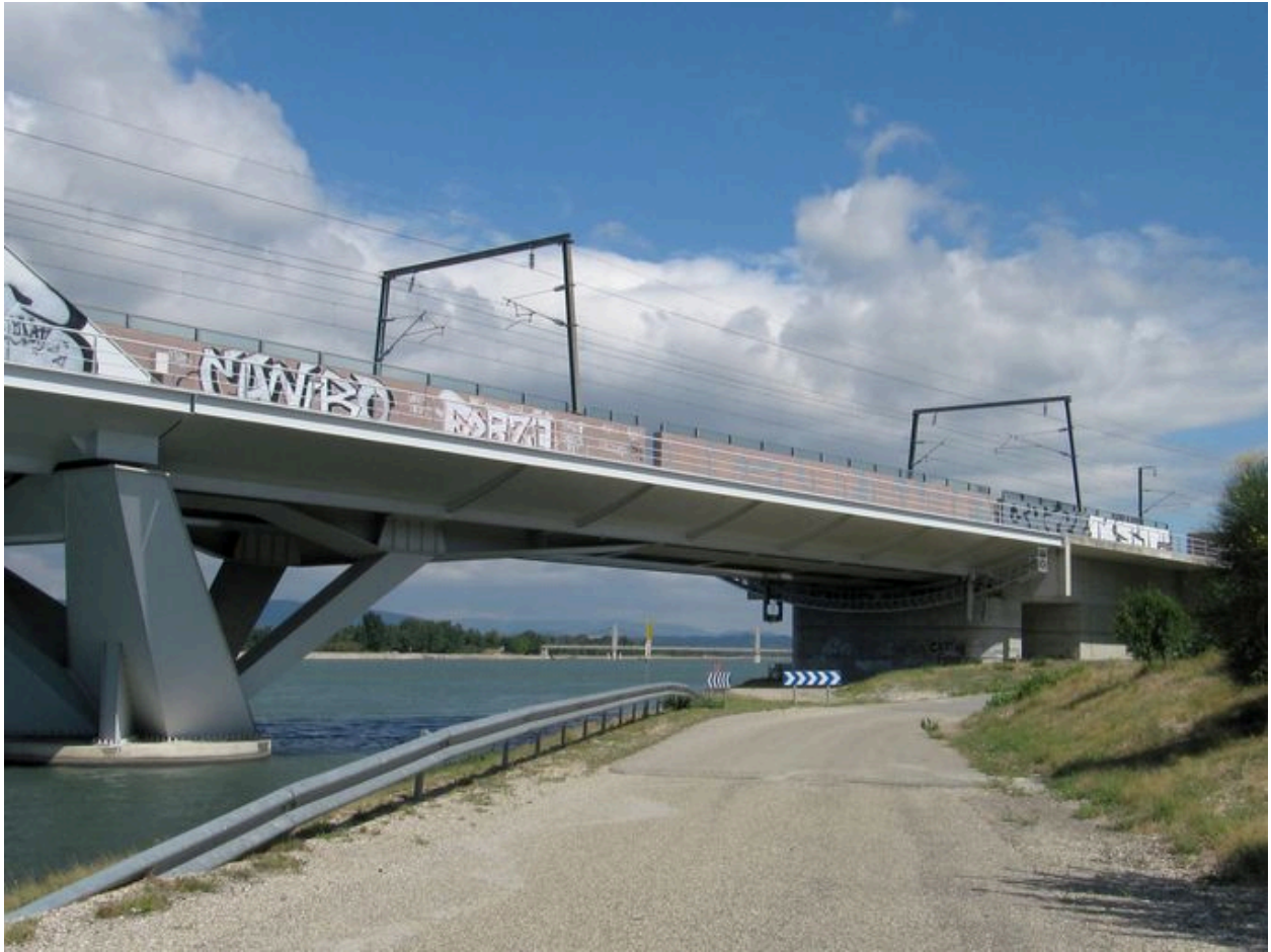
Vue partielle, culée et travée gauche, face aval (depuis la rive gauche)
