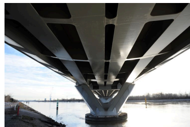
Vue partielle, de dessous, tablier et piles (depuis la rive gauche)
