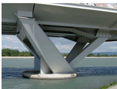
Pile gauche, vue générale, face aval (depuis la rive gauche) Phot. I. Havard IVR82_20102600205NUCA
