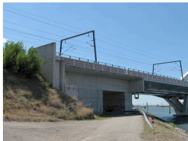
Culée gauche, face amont, vue générale (depuis la rive gauche) Phot. I. Havard IVR82_20102600200NUCA
