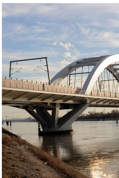
Vue partielle, pile gauche, face amont (depuis la rive gauche) Phot. G. Gellert IVR82_20102600204NUCA
