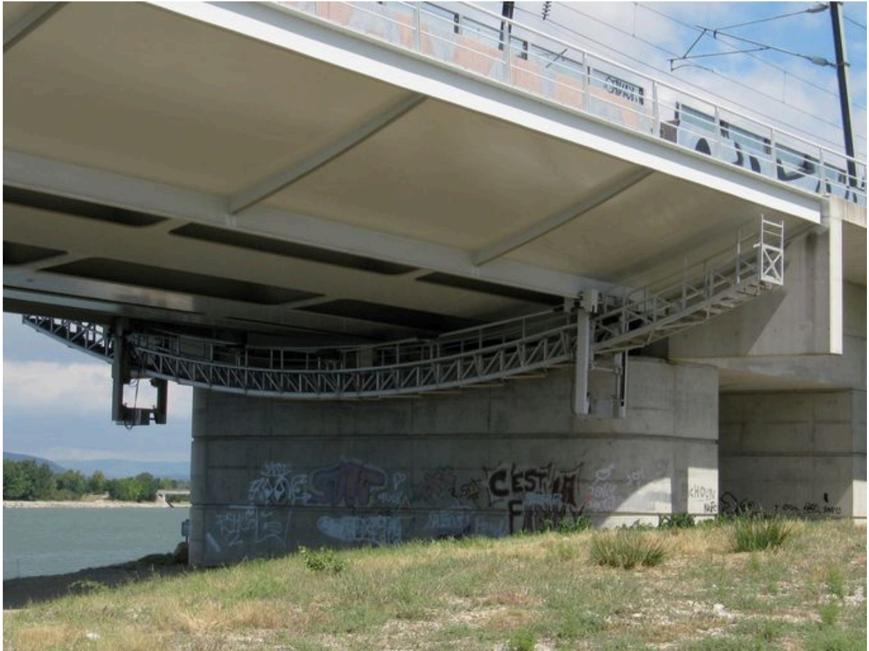
Culée gauche, de dessous, face aval, vue générale (depuis la rive gauche)
