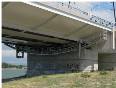
Culée gauche, de dessous, face aval, vue générale (depuis la rive gauche) Phot. I. Havard IVR82_20102600201NUCA
