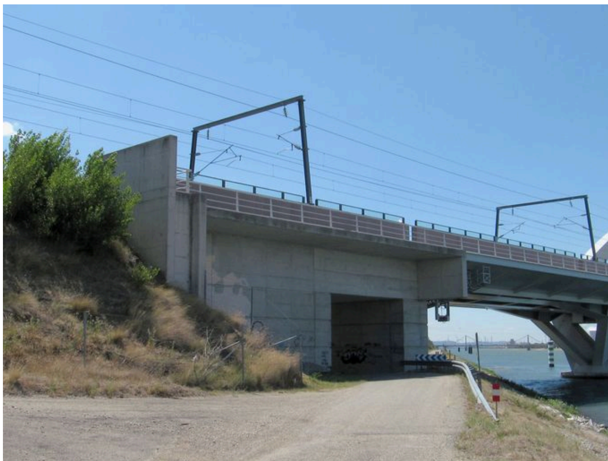
Culée gauche, face amont, vue générale (depuis la rive gauche)
