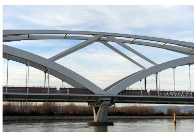
Bow-strings, face aval, vue partielle (depuis la rive gauche) Phot. G. Gellert IVR82_20102600208NUCA
