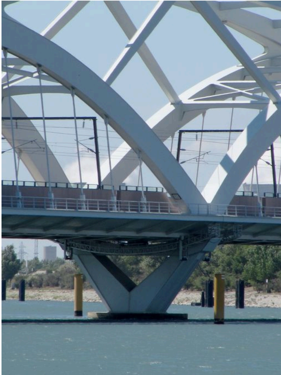
Arcs, face amont, vue partielle : jonction au-dessus de la pile centrale (depuis la rive gauche)
