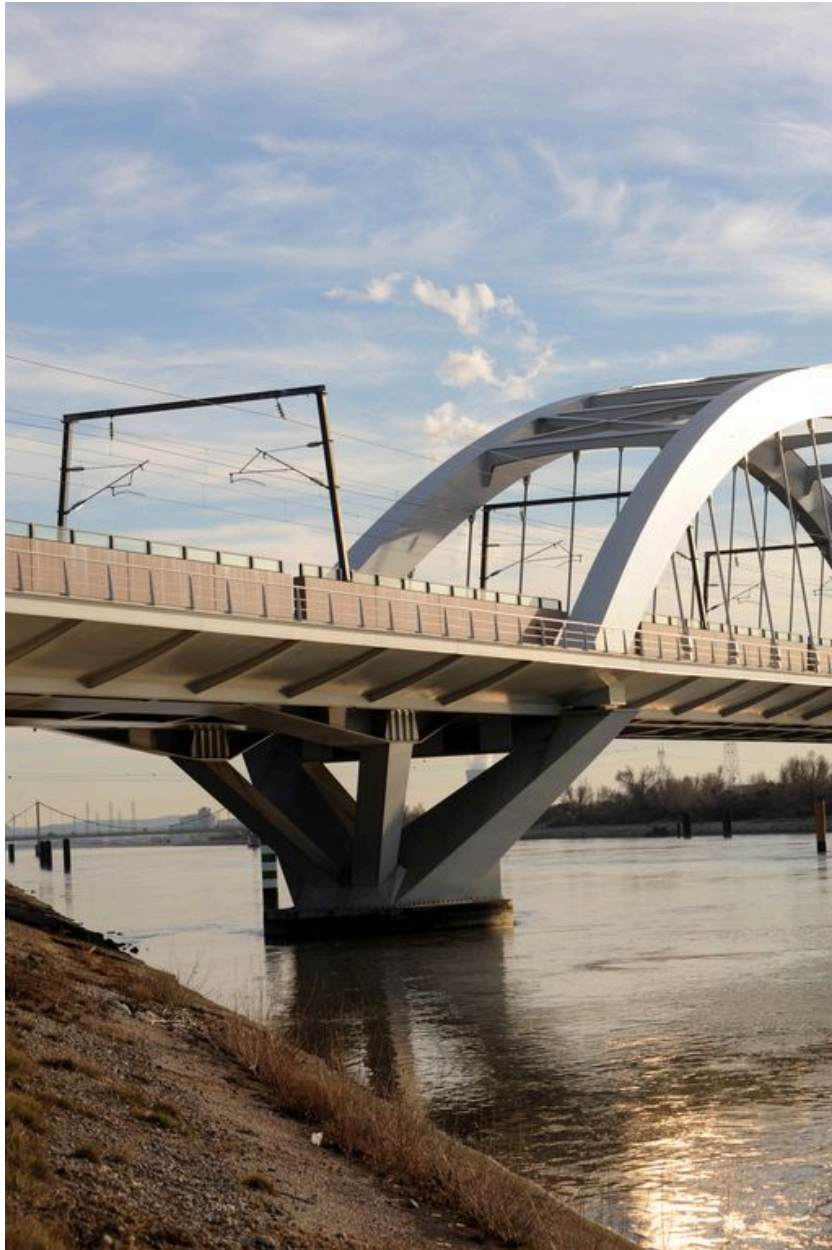
Vue partielle, pile gauche, face amont (depuis la rive gauche)
