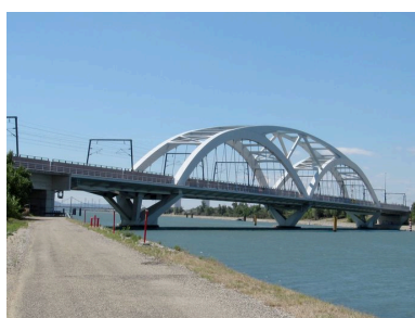
Vue générale, face amont (depuis la rive gauche) Phot. I. Havard IVR82_20102600195NUCA
