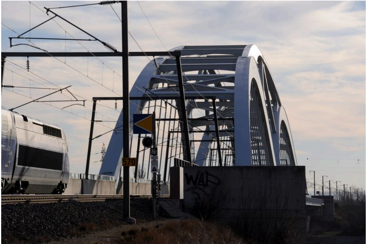
Vue partielle, de dessus, bow-strings et voie ferrée (depuis la rive gauche)
