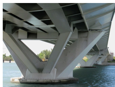
Pile gauche, de côté, face amont, vue générale (depuis la rive gauche) Phot. I. Havard IVR82_20102600206NUCA
