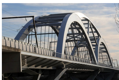
Bow-strings, de côté, face amont, vue générale (depuis la rive gauche) Phot. G. Gellert IVR82_20102600207NUCA
