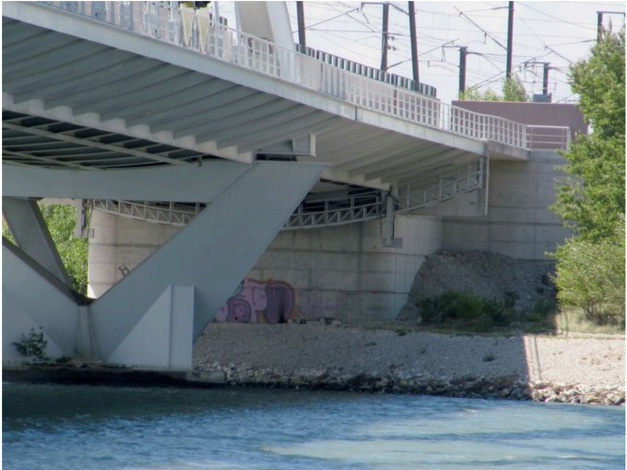
Culée droite, de côté, face amont, vue générale (depuis la rive gauche)
