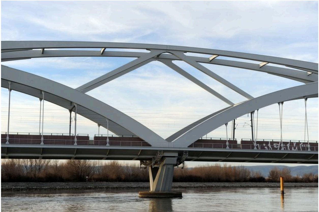
Bow-strings, face aval, vue partielle (depuis la rive gauche)
