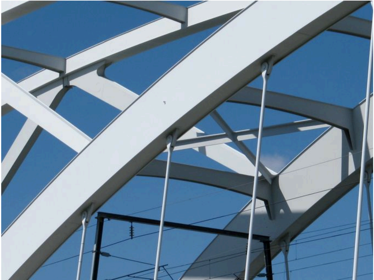
Arc, face aval, vue de détail : jonction avec les suspentes (depuis la rive gauche)
