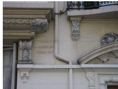
Détail de la signature de l'architecte Phot. Cendrine Sanquer IVR82_20084200540NUCA
