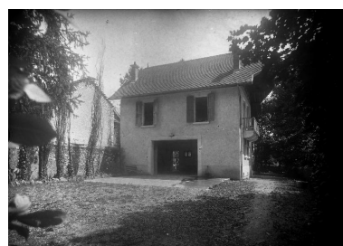
Vue sur le garage, façade nord, vers 1930 Repro. Denys Harreau IVR82_20147300002NUCB
