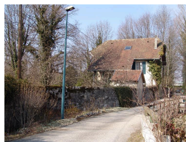
Vue d'ensemble depuis le chemin des Combaruches Phot. François Fouger IVR82_20147300811NUCA
