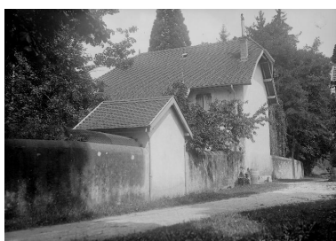
Vue depuis le sud-est, vers 1930 Repro. Denys Harreau IVR82_20147300001NUCB
