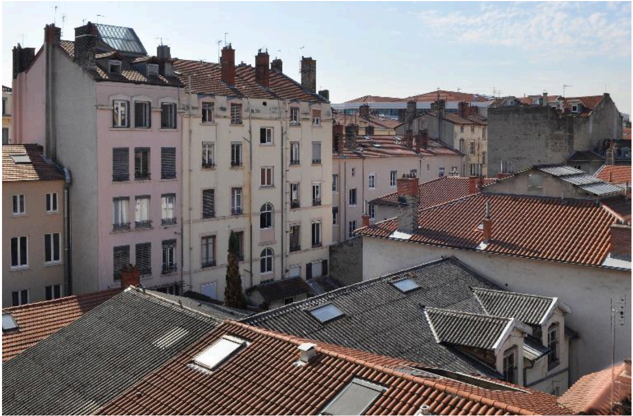
Elévation sur cour, surélévation lisible à la modification des baies de l'escalier
