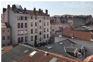
Elévation sur cour, surélévation lisible à la modification des baies de l'escalier Phot. Catherine Guégan IVR82_20156901149NUCA
