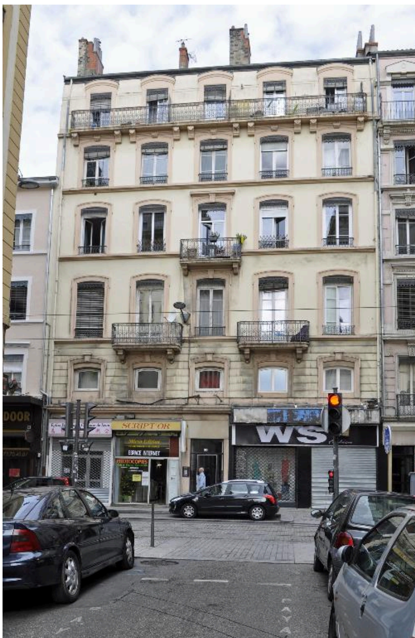
Elévation sur rue, vue générale
