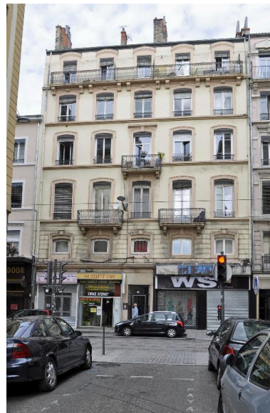
Elévation sur rue, vue générale Phot. Catherine Guégan IVR82_20156901150NUCA
