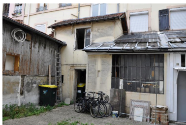
Vue partielle des bâtiments sur cour : hangar en pisé et essentage de planches, loge de concierge, hangar en pan de métal Phot. Catherine Guégan IVR82_20156901155NUCA
