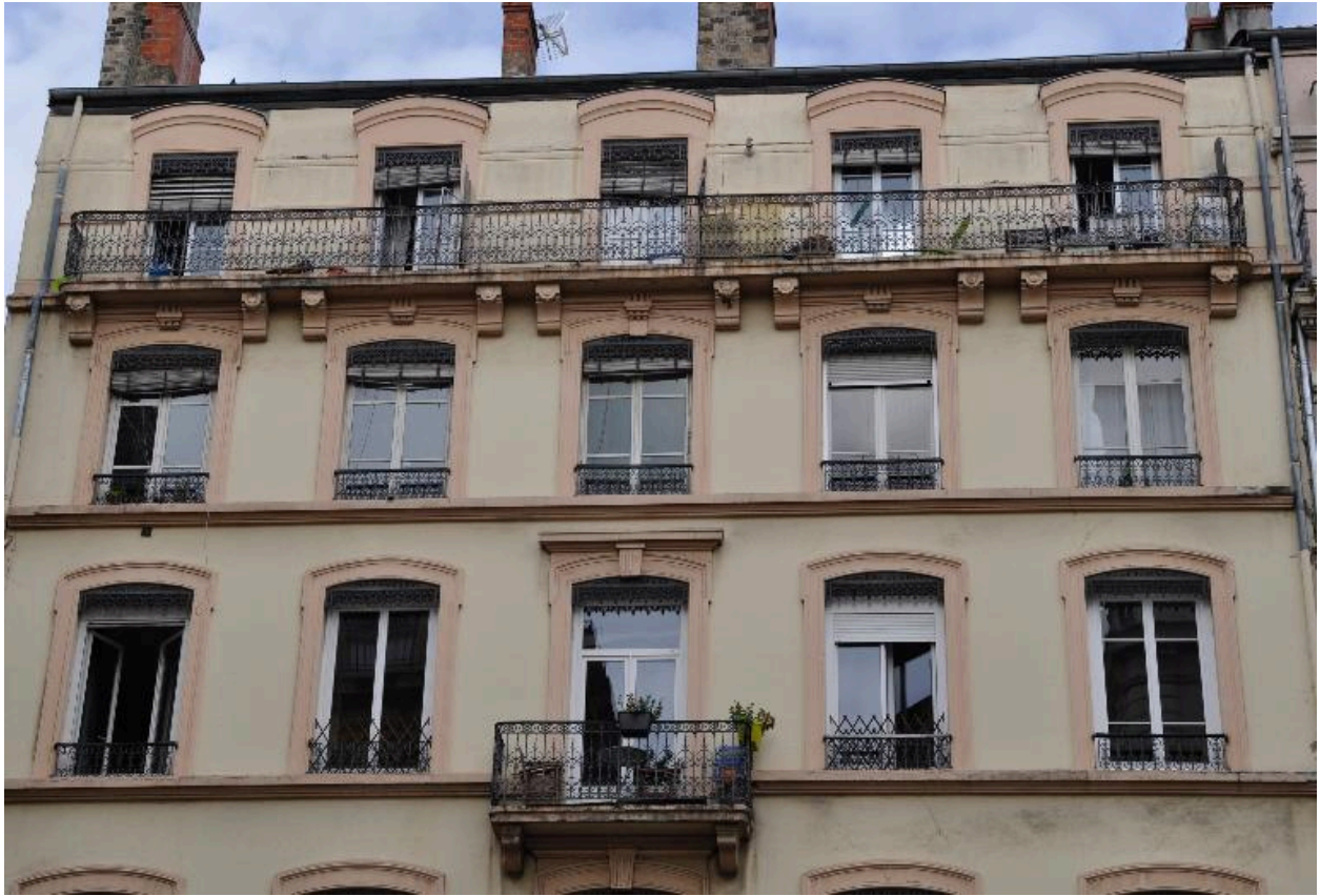
Elévation sur rue, vue rapprochée des niveaux en surélévation
