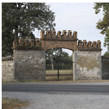
Vue du portail de l'angle nord-ouest du parc. Phot. Eric Dessert IVR82_20054200891NUCA
