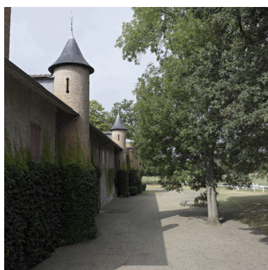
Vue de l'aile nord, côté parc, depuis l'ouest. Phot. Eric Dessert IVR82_20054200896NUCA
