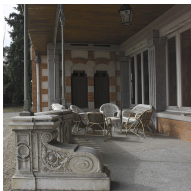
Vue de la galerie ouverte devant la maison des maîtres, depuis le nord. Phot. Eric Dessert IVR82_20054200894NUCA
