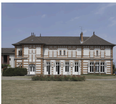
Vue de la maison des maîtres, élévation arrière, depuis l'est. Phot. Eric Dessert IVR82_20054200883NUCA
