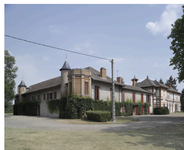
Vue d'ensemble depuis le nord-est. Phot. Eric Dessert IVR82_20054200884NUCA
