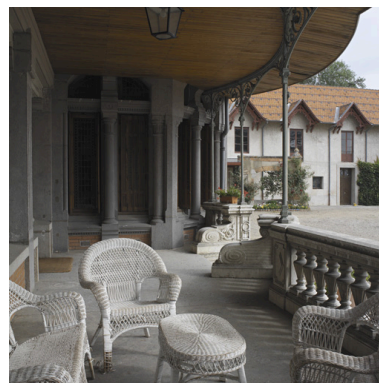
Vue de la galerie ouverte devant la maison des maîtres, depuis le sud. Phot. Eric Dessert IVR82_20054200895NUCA
