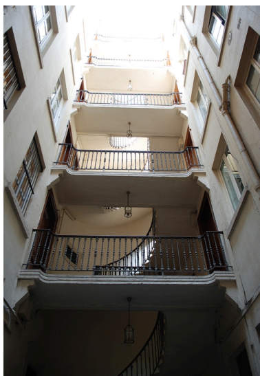
Escalier ouest : vue en contre-plongée Phot. Véronique Belle IVR82_20096904821NUCA
