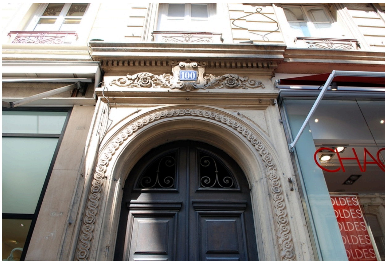
Elévation antérieure : détail de la porte
