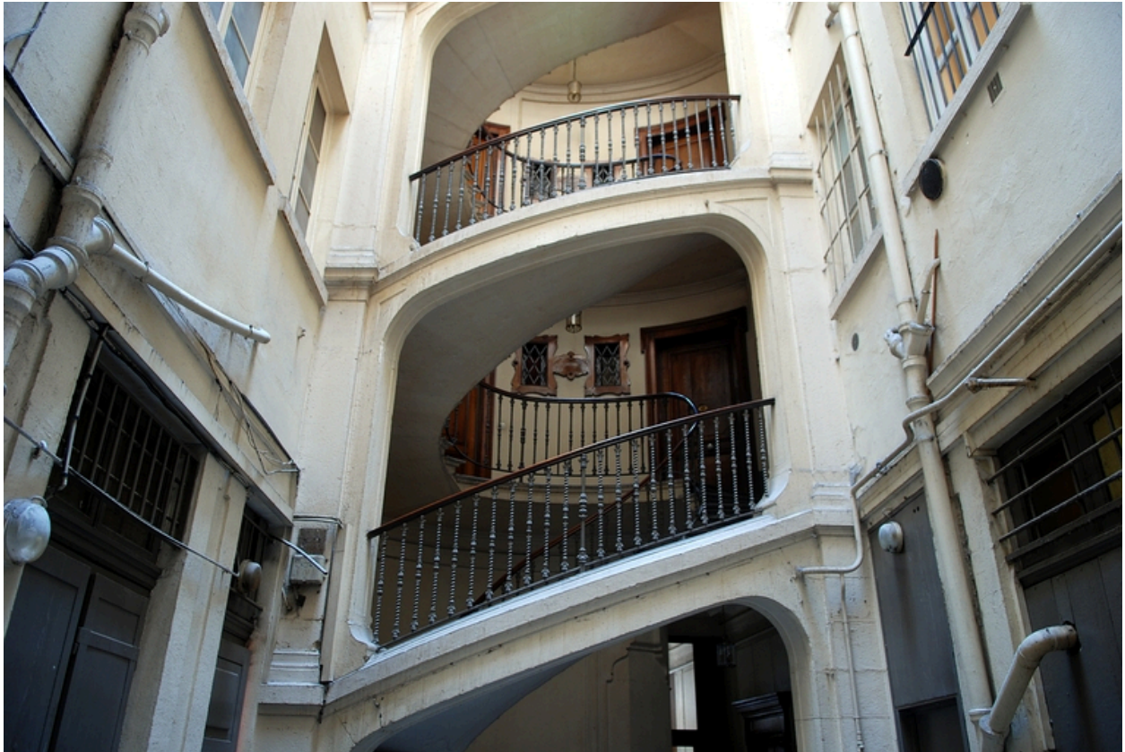
Escalier est : détail de deux volées
