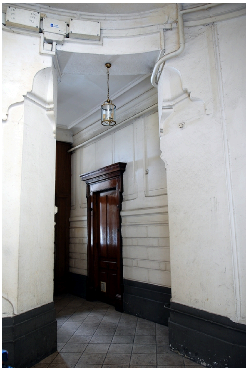
Jonction de l'allée avec la cage d'escalier est
