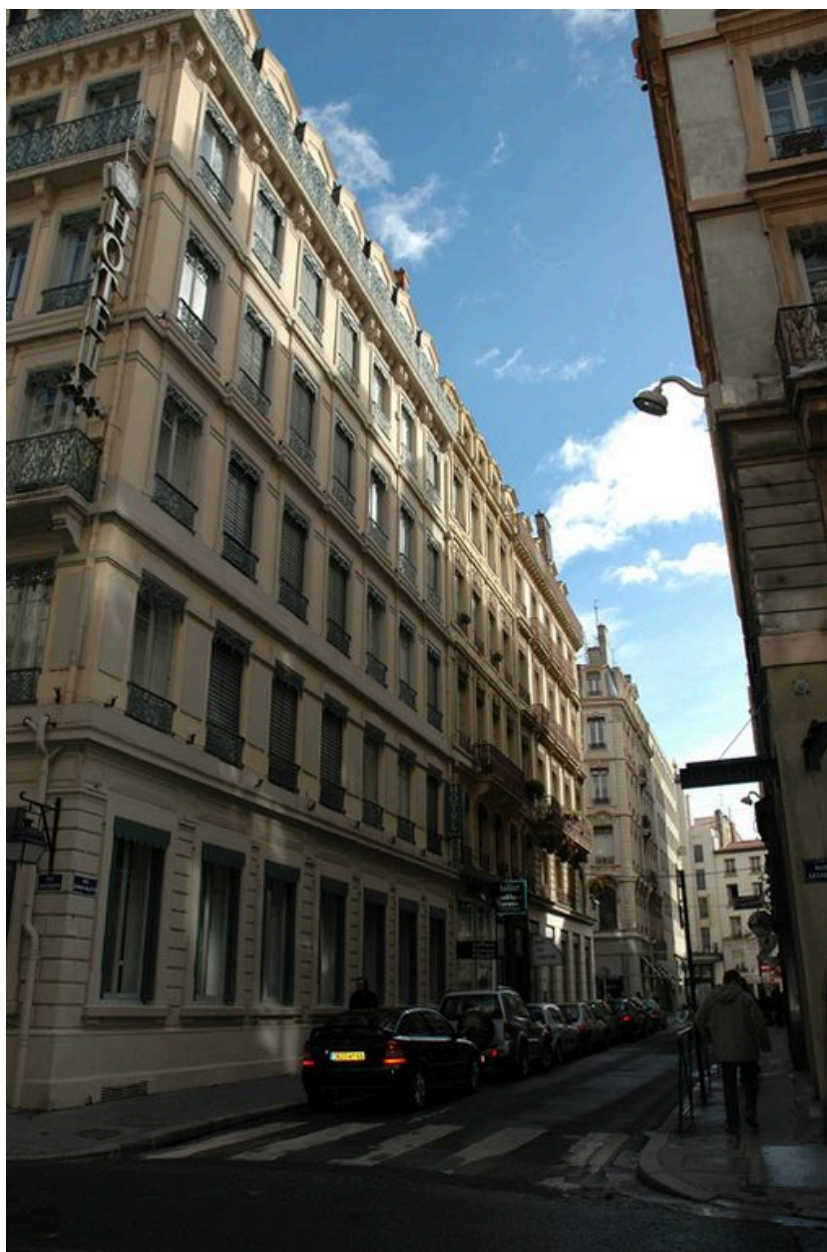
Vue de situation de l'élévation rue Simon-Maupin
