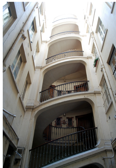
Escalier est : vue en contre-plongée Phot. Véronique Belle IVR82_20096904813NUCA
