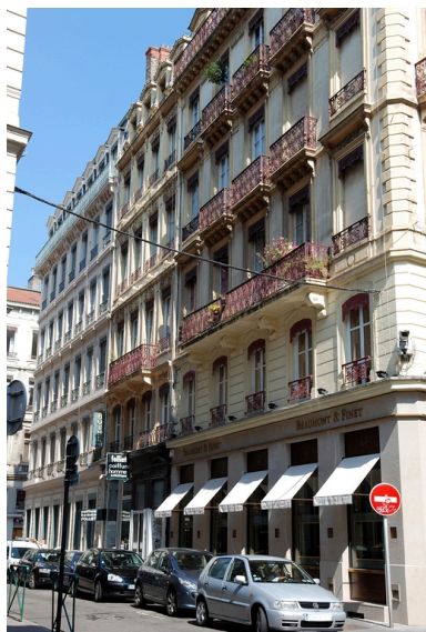
Elévation rue Simon-Maupin Phot. Véronique Belle IVR82_20096904805NUCA
