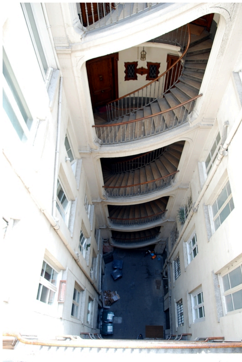
Vue en plongée de la cour depuis l'escalier ouest
