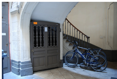
Accès à la cave sous l'escalier est Phot. Véronique Belle IVR82_20096904812NUCA
