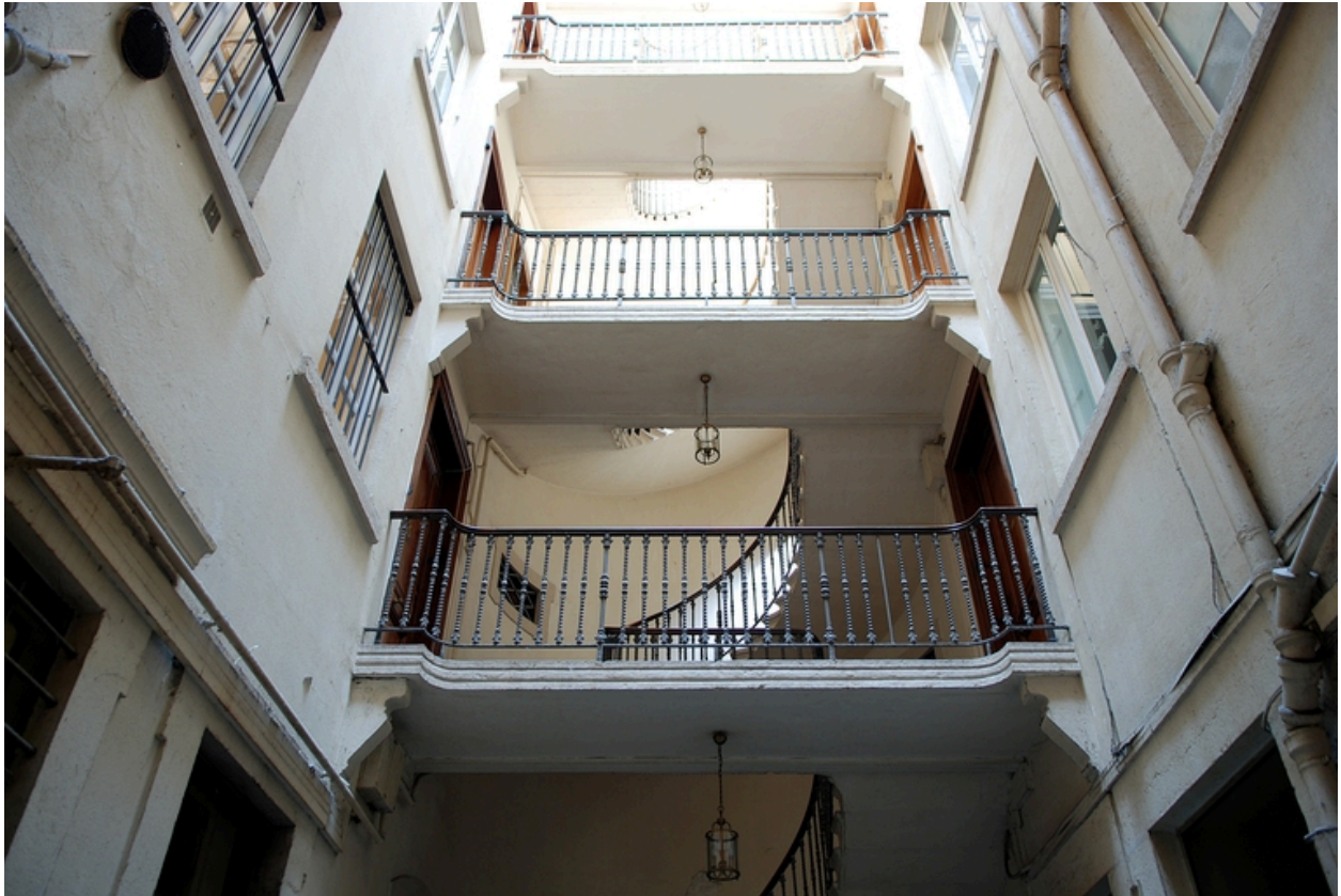
Escalier ouest : détail de deux volées
