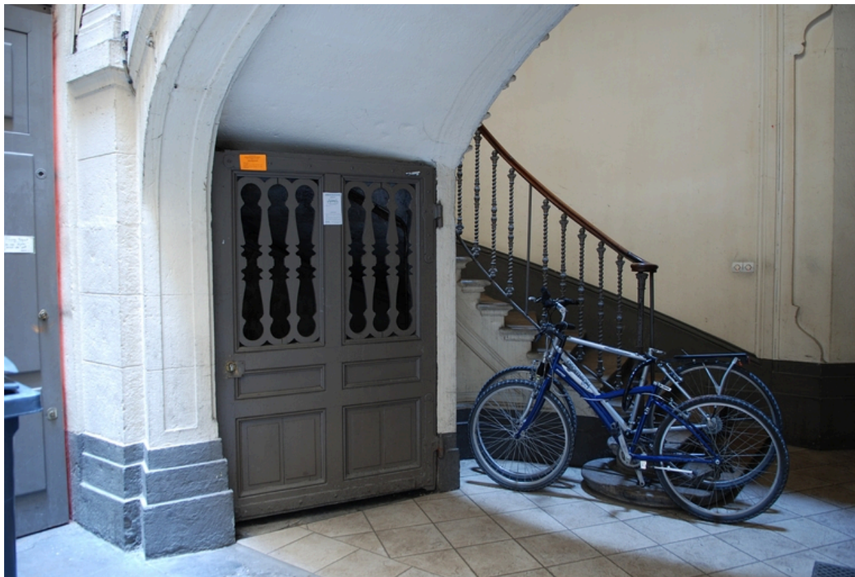
Accès à la cave sous l'escalier est
