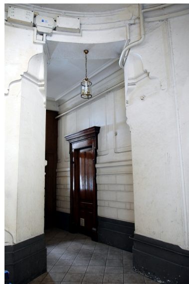
Jonction de l'allée avec la cage d'escalier est Phot. Véronique Belle IVR82_20096904810NUCA
