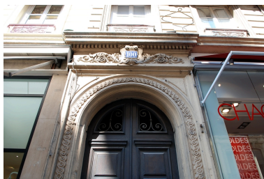
Elévation antérieure : détail de la porte Phot. Véronique Belle IVR82_20096904809NUCA
