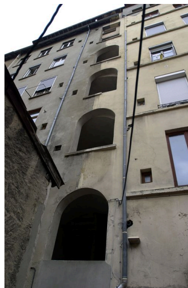
Façade sur cour, baies de la cage d'escalier, vue générale Phot. Véronique Belle IVR82_20036902120NUCA
