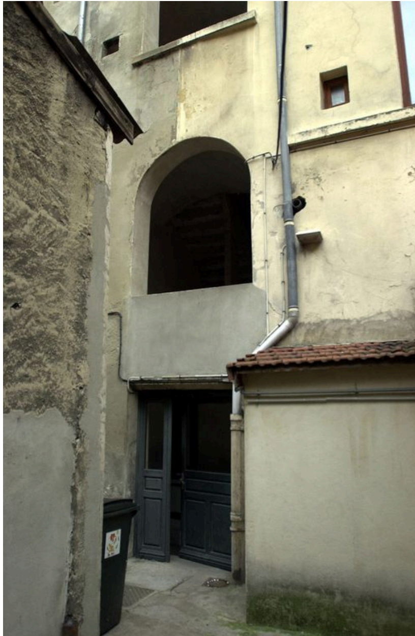
Façade sur cour, baies de la cage d'escalier, rez-de-chaussée et premier étage
