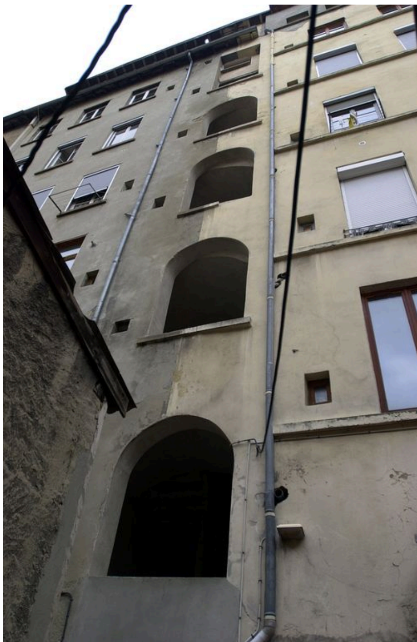
Façade sur cour, baies de la cage d'escalier, vue générale
