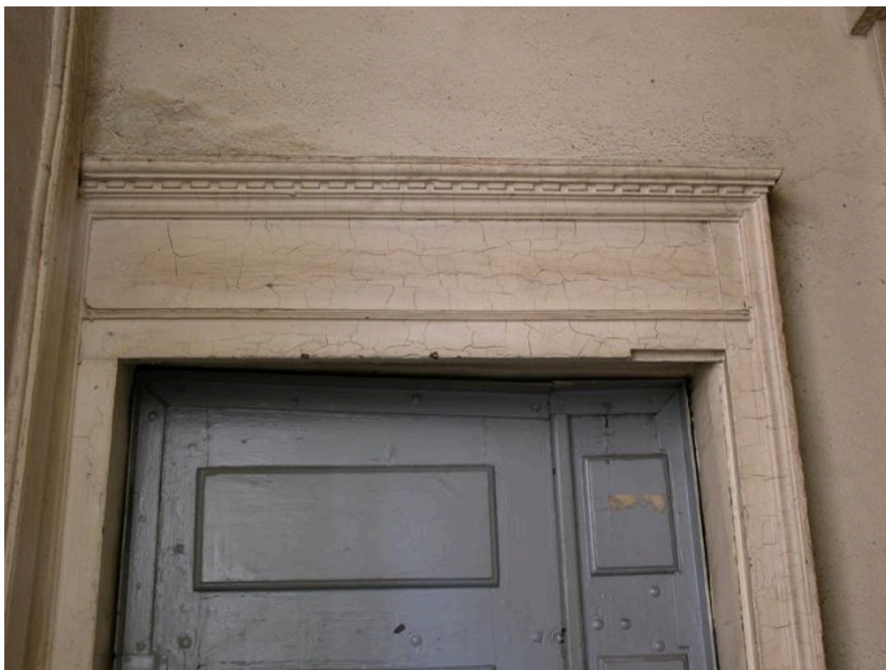
Escalier, palier du 2e étage, détail de la porte ouest
