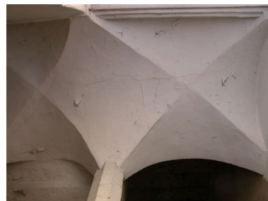
Escalier, voûtes du palier du 1er étage Phot. Bernard Ducouret IVR82_20046905819NUCA
