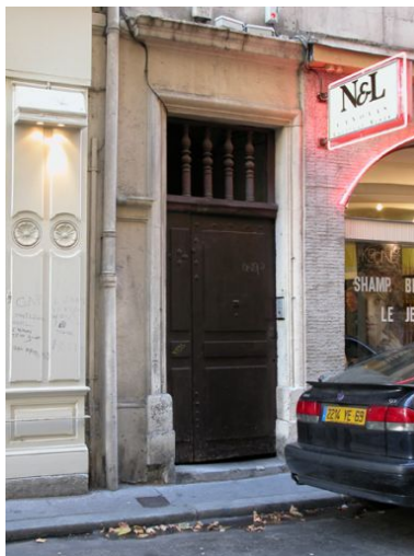
Façade rue des Forces, porte Phot. Bernard Ducouret IVR82_20046905818NUCA
