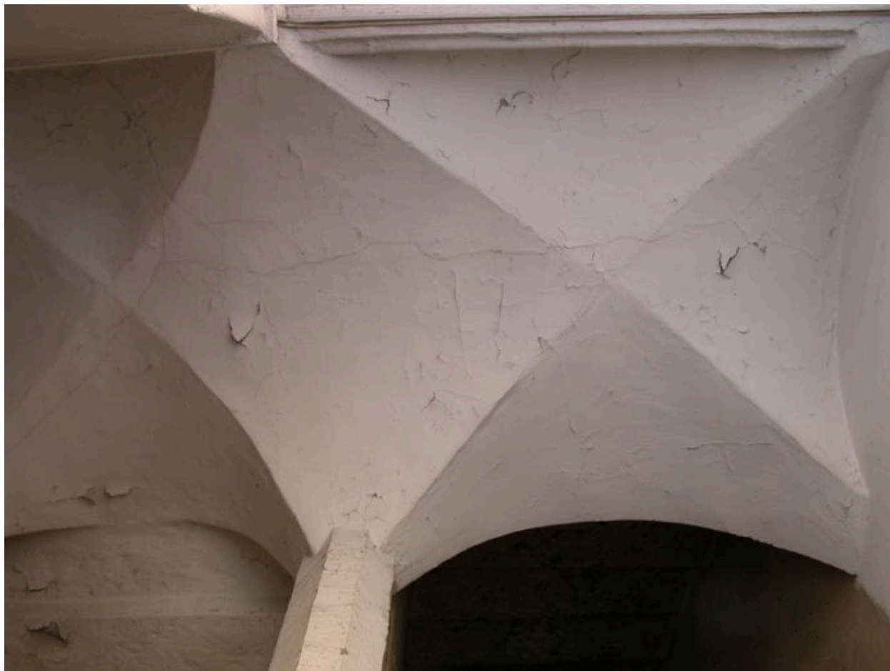
Escalier, voûtes du palier du 1er étage
