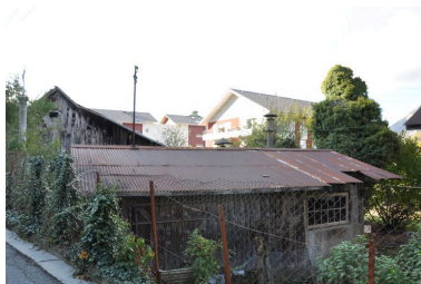
Remise fermant la propriété au nord-est Phot. Samir Mahfoudi, Autr. Samir Mahfoudi IVR82_20117401041NUCA
