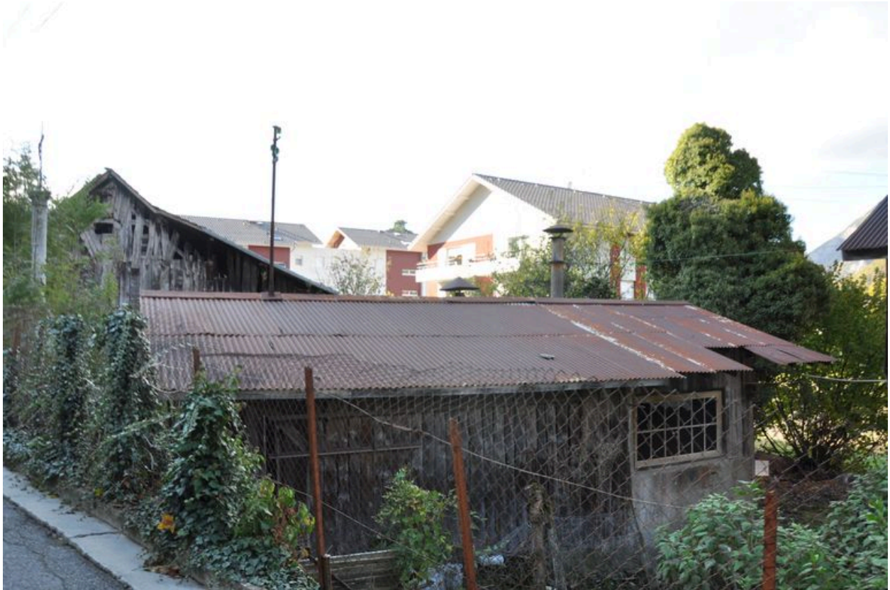
Remise fermant la propriété au nord-est
