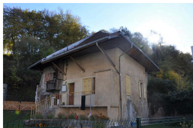
Bâtiment attenant à la propriété constituant une annexe de l'ancienne filature de Faverges Phot. Samir Mahfoudi, Autr. Samir Mahfoudi IVR82_20117401040NUCA
