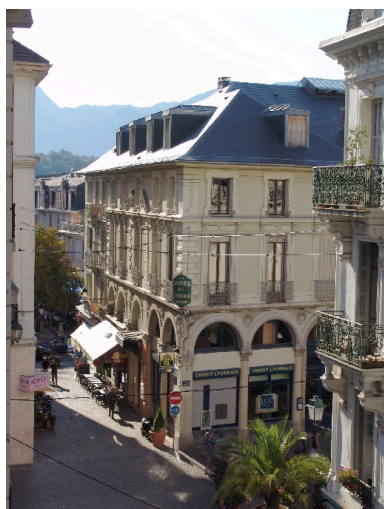
Vue sur la rue des Bains Phot. François Fouger IVR82_20057300607NUCA
