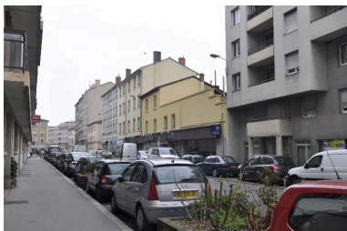
Vue d'ensemble Phot. Maxence Colleau IVR82_20136900291NUCA
