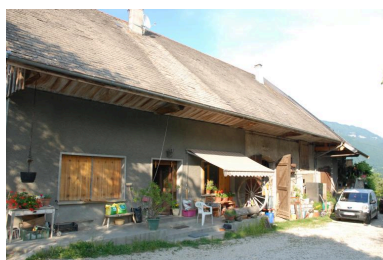
Ferme (2016 B7 432), non repérée. Phot. Thierry Monnet IVR84_20207400548NUCA
