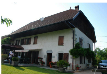
Maison (2016 B7 437), non repérée. Phot. Thierry Monnet IVR84_20207400550NUCA
