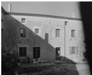
Elévation principale du logis sur cour. Phot. Alain Franchella IVR82_20002600097X
