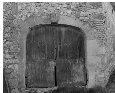
Elévation postérieure : portail d'entrée dans une dépendance. Phot. Alain Franchella IVR82_20002600094X
