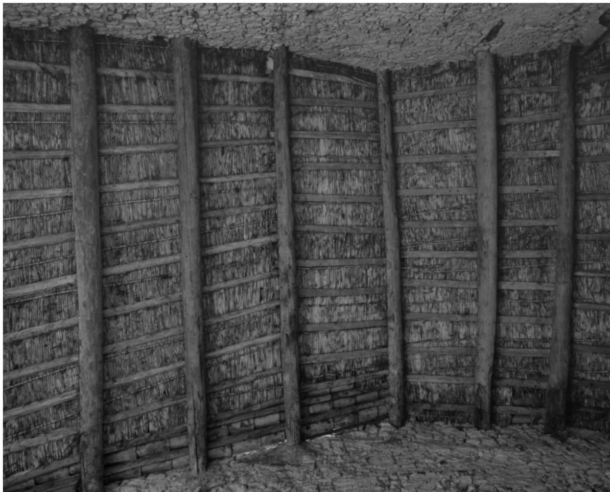
Détail d'une charpente en bois et canisse.
