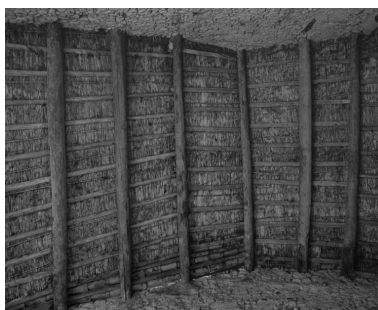
Détail d'une charpente en bois et canisse. Phot. Alain Franchella IVR82_20002600095X
