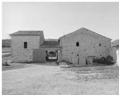
Elévation est et entrée de la ferme. Phot. Alain Franchella IVR82_20002600102X
