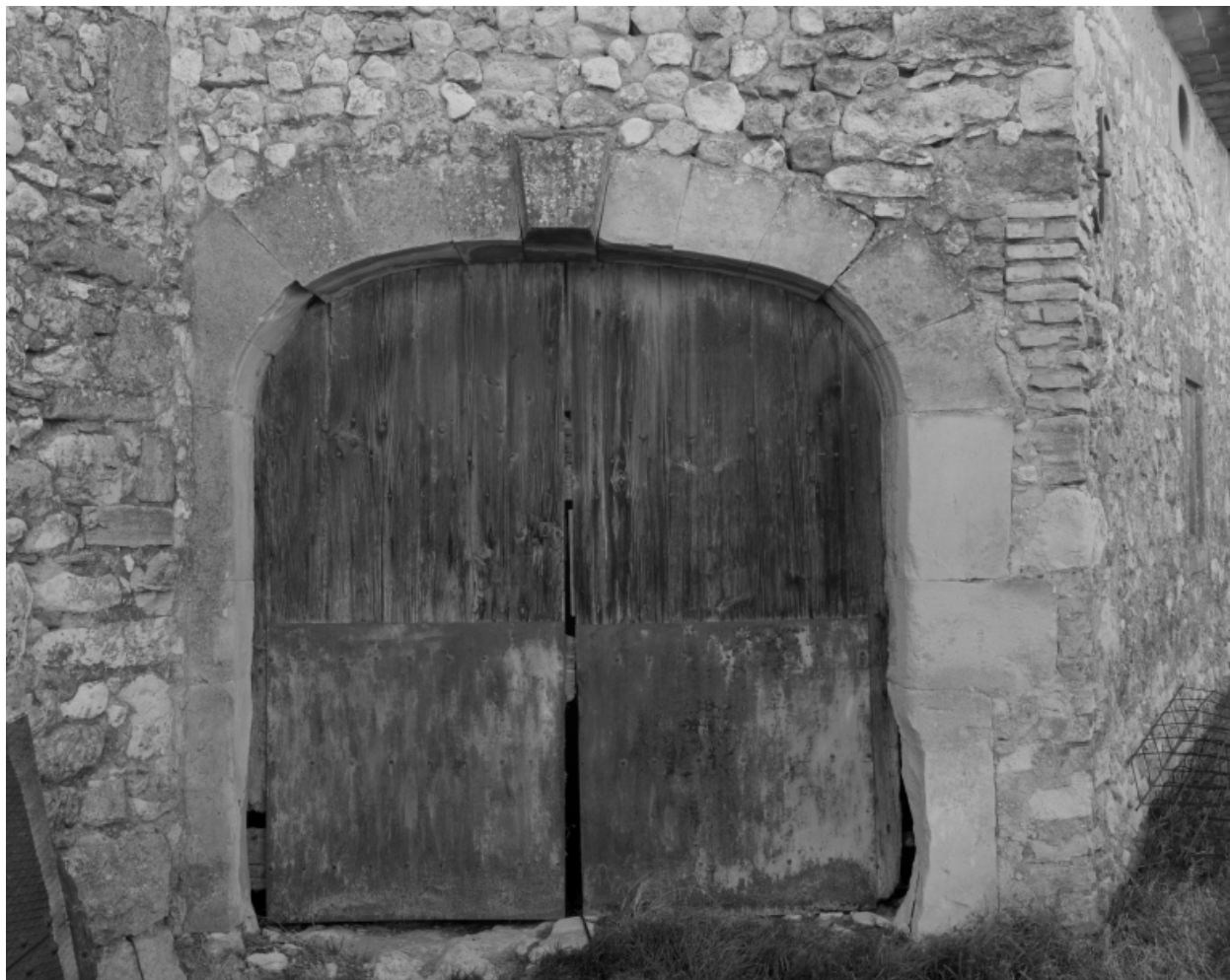
Elévation postérieure : portail d'entrée dans une dépendance.
