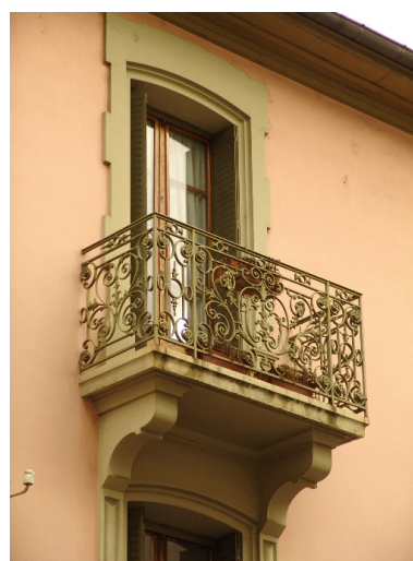
Détail d'un balcon Phot. François Fouger IVR82_20067300765NUCA
