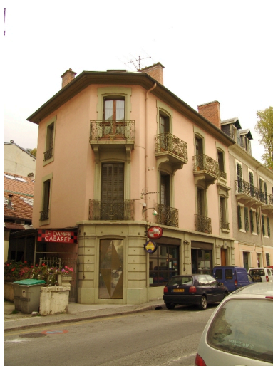
Vue d'ensemble Phot. François Fouger IVR82_20067300763NUCA
