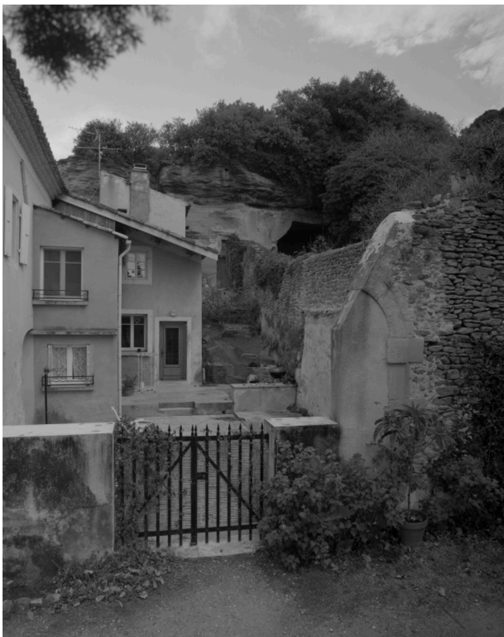
Vue du site dans lequel est aménagé l'habitat troglodytique.
