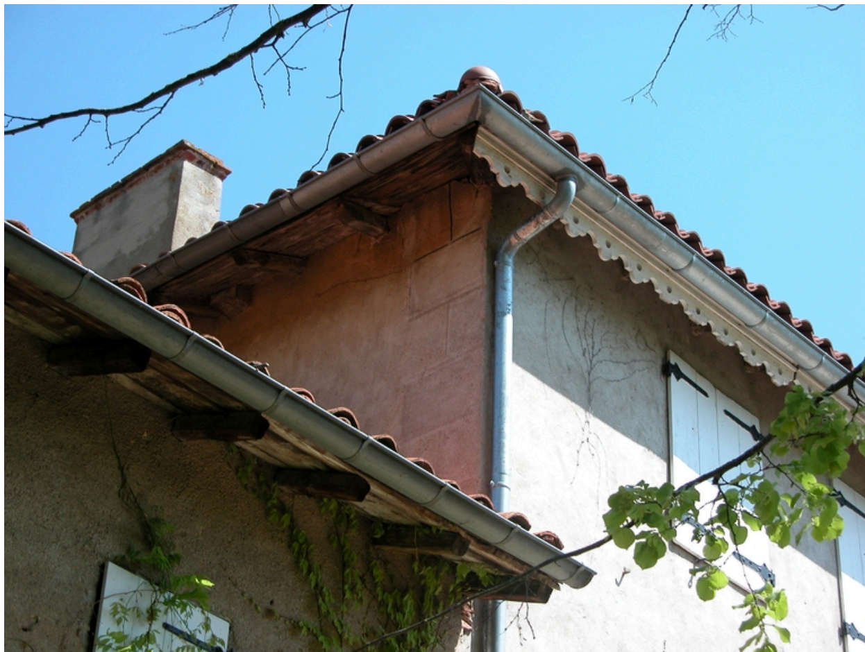
Détail de l'angle sud-ouest du logis : vestige d'enduit peint (chaînage).
