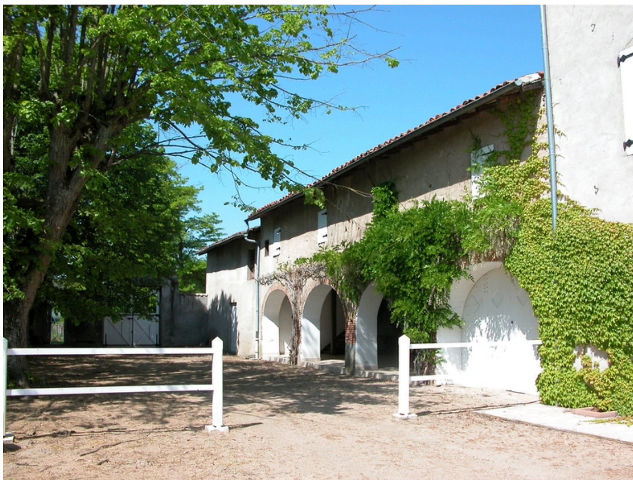
Vue d'ensemble de la dépendance depuis le sud-est.
