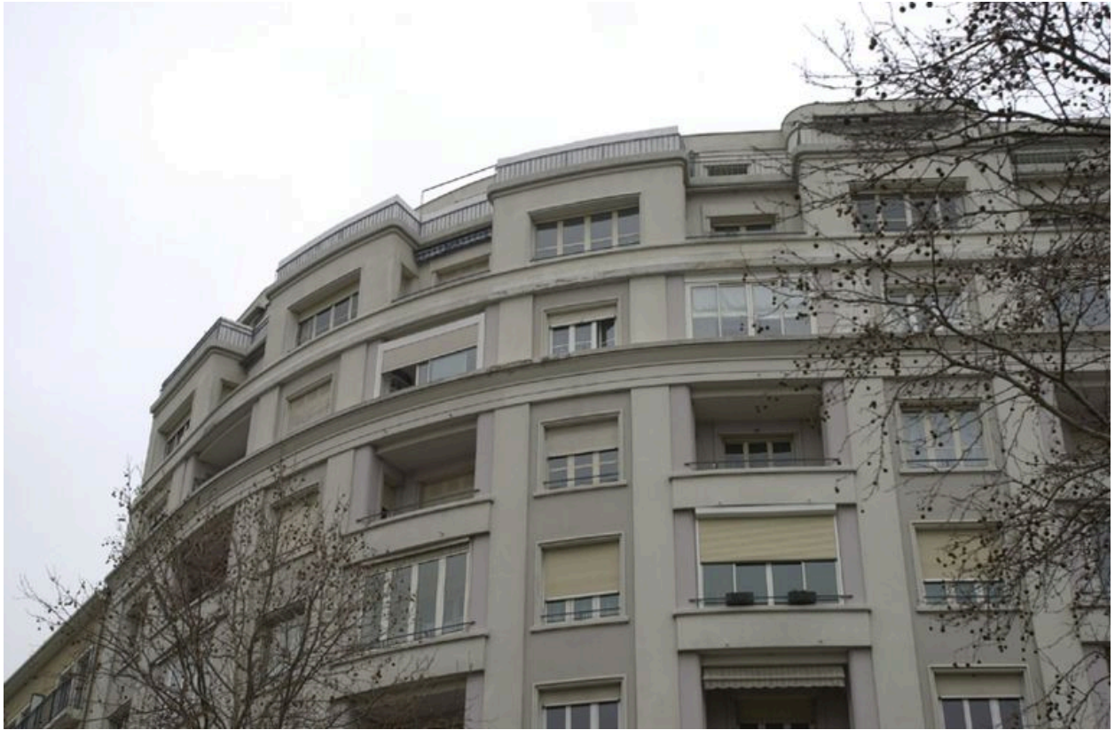
Détail des étages supérieurs
