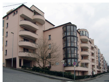
Vue prise du sud Phot. François Fouger IVR82_20097300178NUCA
