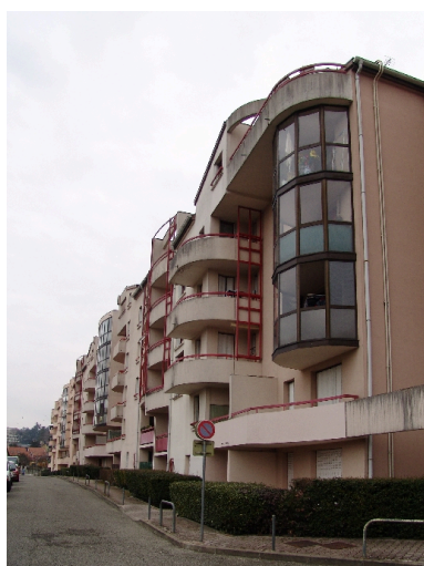
Façade principale prise du nord Phot. François Fouger IVR82_20097300177NUCA
