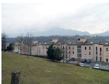
Vue dans le site Phot. François Fouger IVR82_20097300093NUCA
