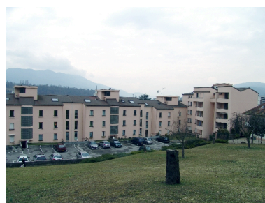
Façades postérieures depuis le parc Phot. François Fouger IVR82_20097300091NUCA
