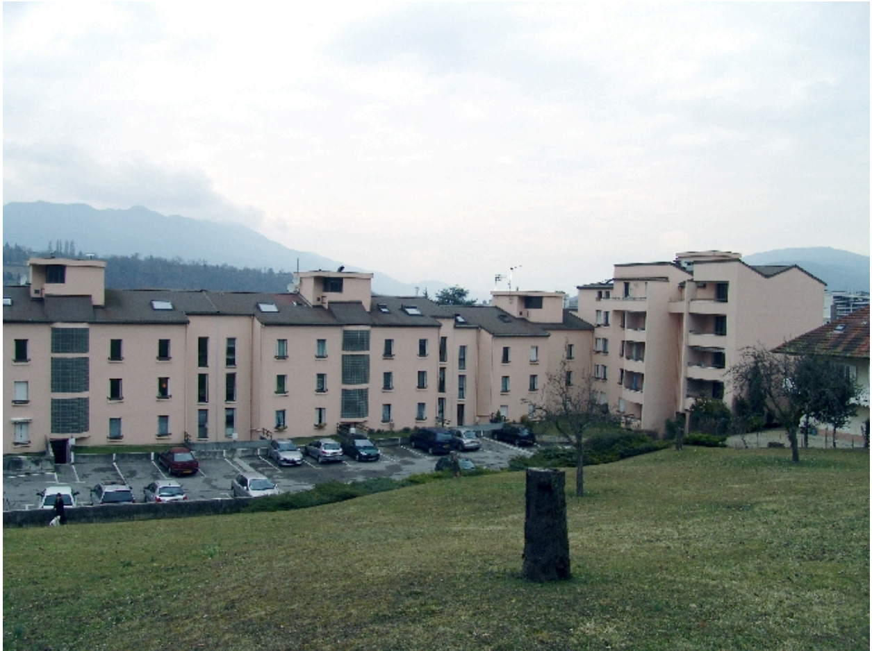
Façades postérieures depuis le parc
