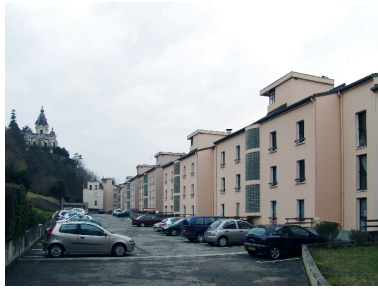
Façade postérieure vue de trois-quart Phot. François Fouger IVR82_20097300090NUCA
