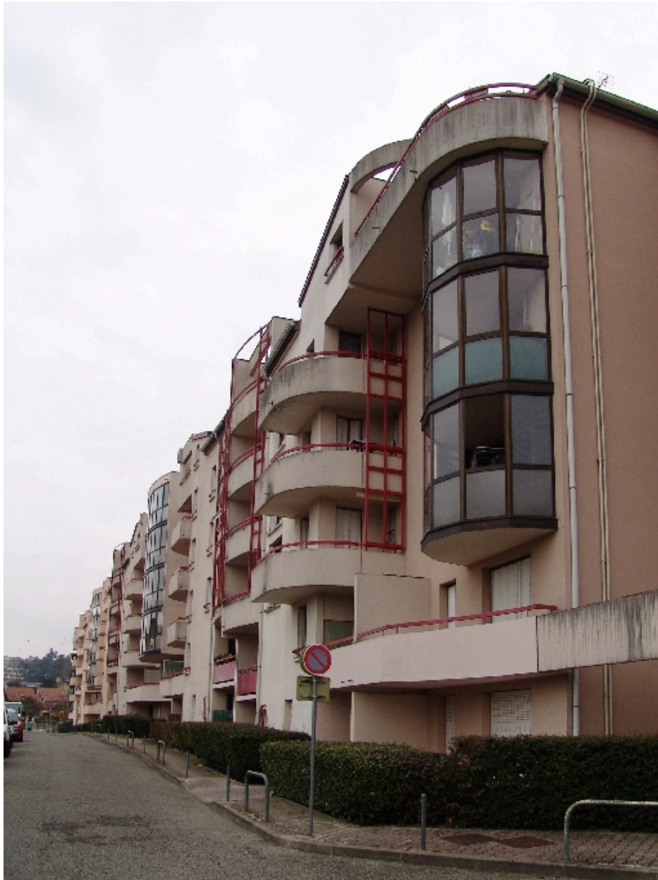
Façade principale prise du nord
