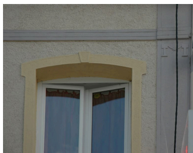
Détail, fenêtre et décor en bas-relief sur pilastre. Phot. Simone Hartmann-Nussbaum IVR82_20124201221NUCA
