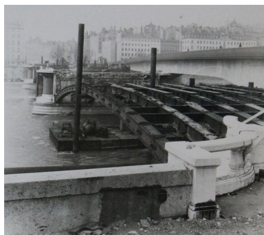
[Ancien pont Morand lors de sa démolition] / E. Poix ou Edmond Pernet phot., [1975]. 1 fotogr. pos. : n. et b. ; 13 x 18 cm (AM Lyon. 8 Ph 04627) Phot. F. Bardoneschi, Autr. E. (? Poix, Autr. Edmond (? Pernet IVR82_20106902736NUCAB
