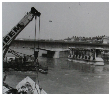
[Ancien pont Morand lors de sa démolition] / E. Poix ou Edmond Pernet phot., [1975]. 1 fotogr. pos. : n. et b. ; 13 x 18 cm (AM Lyon. 8 Ph 04630) Phot. F. Bardoneschi, Autr. E. (? Poix, Autr. Edmond (? Pernet IVR82_20106902737NUCAB
