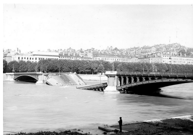
[L'arche dynamitée en septembre 1944]. 1944. 1 fotogr. : n. et b. (AM Lyon. 3 Ph 176) Phot. AM Lyon IVR82_20106902546NUCAB
