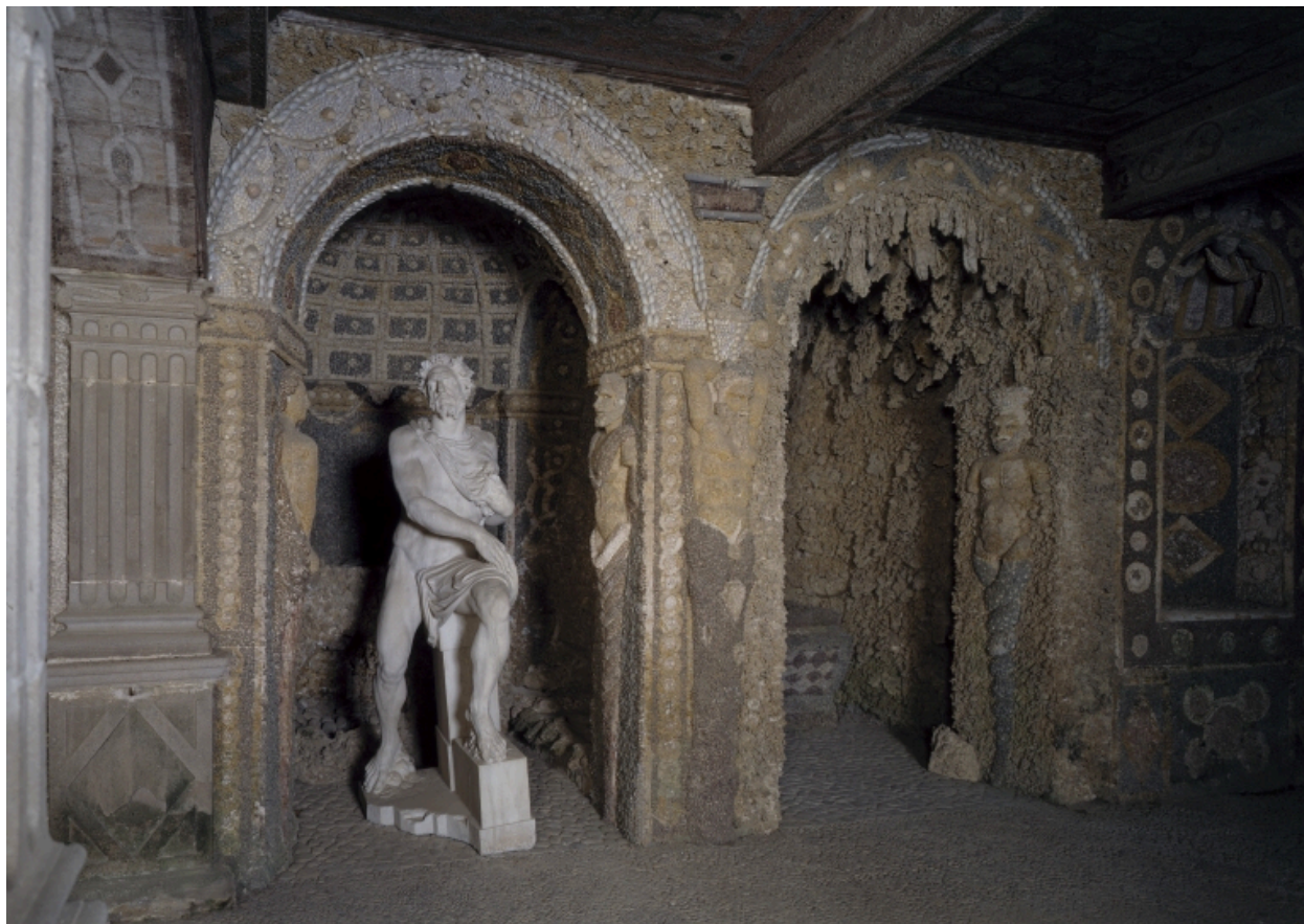
Vue des deux renforcements du mur sud.
