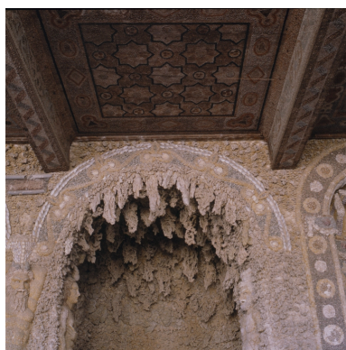
Plafond : détail du décor au sable collé (premier plan) et du décor de rocaille du renforcement de droite.
