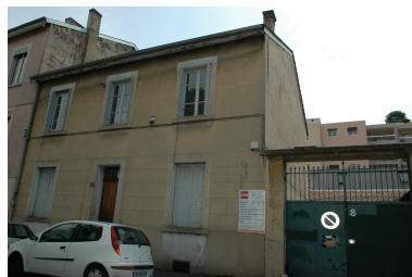
Vue générale de la façade principale, sur rue Phot. Magali Delavenne IVR82_20146902619NUCA
