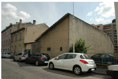
Vue d'ensemble de la façade principale, sur rue Phot. Magali Delavenne IVR82_20146902620NUCA
