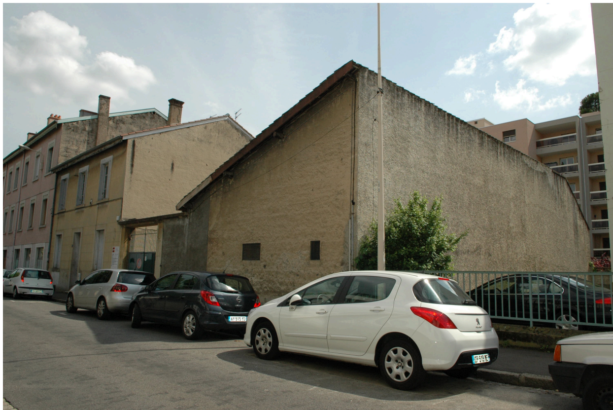
Vue d'ensemble de la façade principale, sur rue
