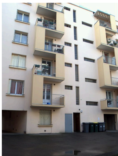
Elévation postérieure, détail des balcons Phot. Maryannick Chalabi IVR82_20116904095NUCA
