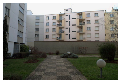
Elévation postérieure, vue des étages supérieurs Phot. Maryannick Chalabi IVR82_20116904094NUCA
