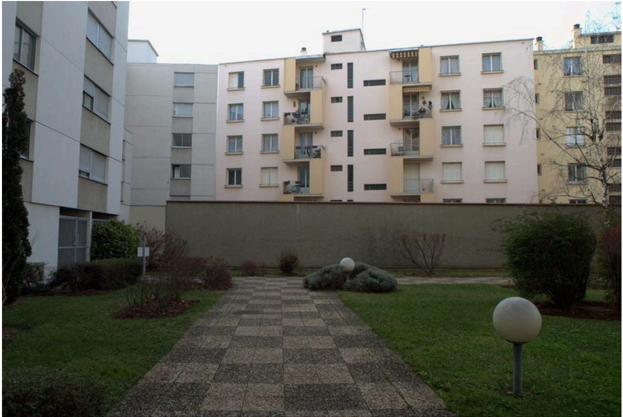
Elévation postérieure, vue des étages supérieurs
