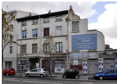
Vue générale Phot. Julien Defillon IVR82_20106900931NUCA
