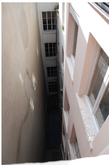
Elévation sur cour Phot. Véronique Belle IVR82_20096904997NUCA
