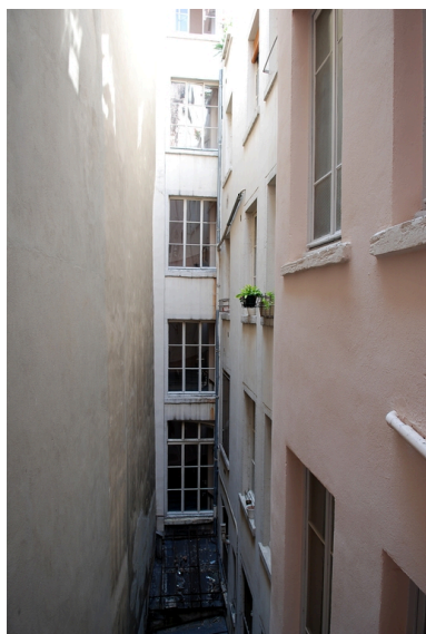
Elévation sur cour Phot. Véronique Belle IVR82_20096904996NUCA
