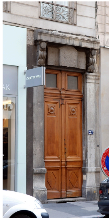
Elévation antérieure : la porte Phot. Véronique Belle IVR82_20096905003NUCA
