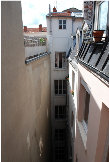
Elévation sur cour Phot. Véronique Belle IVR82_20096904999NUCA
