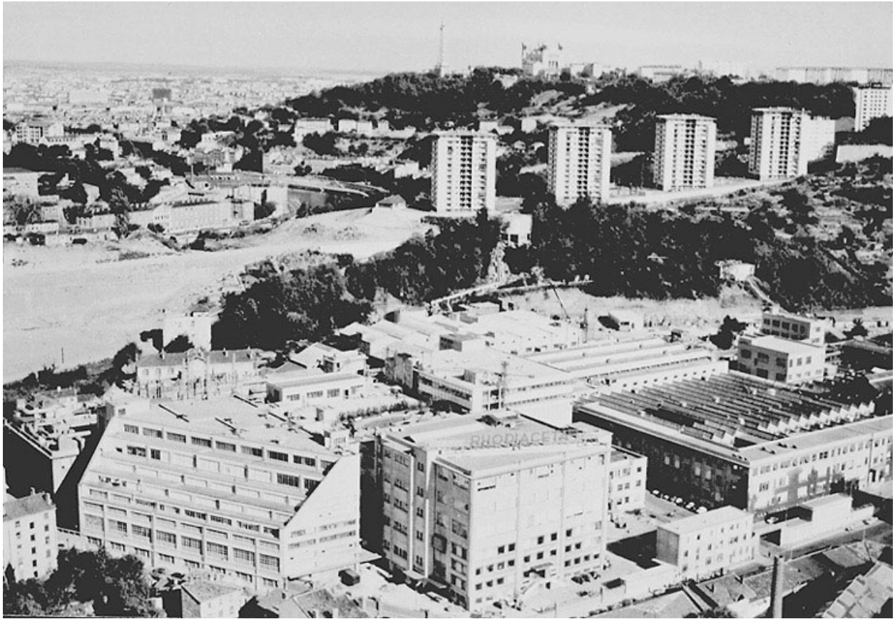
Vue générale du site en 1960
