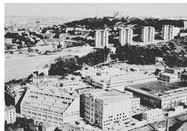
Vue générale du site en 1960 Repro. Martial Couderette IVR82_20016903207XB
