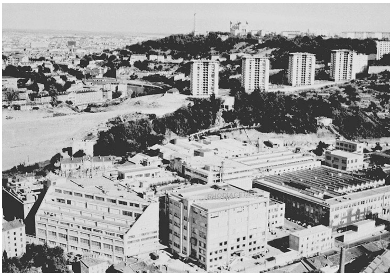
Vue générale du site en 1960
