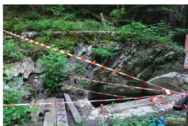
Vue des deux fosses en partie inondée Phot. Yannick Milleret IVR82_20117302258NUCA
