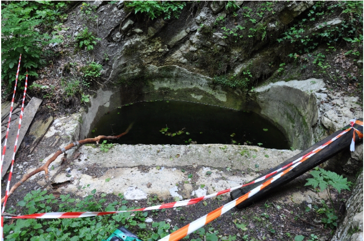
Vue d'une de deux fosses inondée
