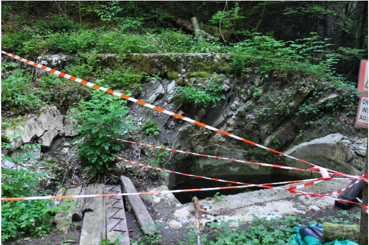
Vue des deux fosses en partie inondée
