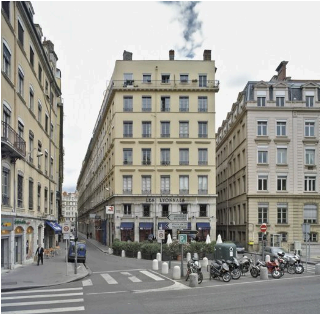
A gauche, l'élévation antérieure
