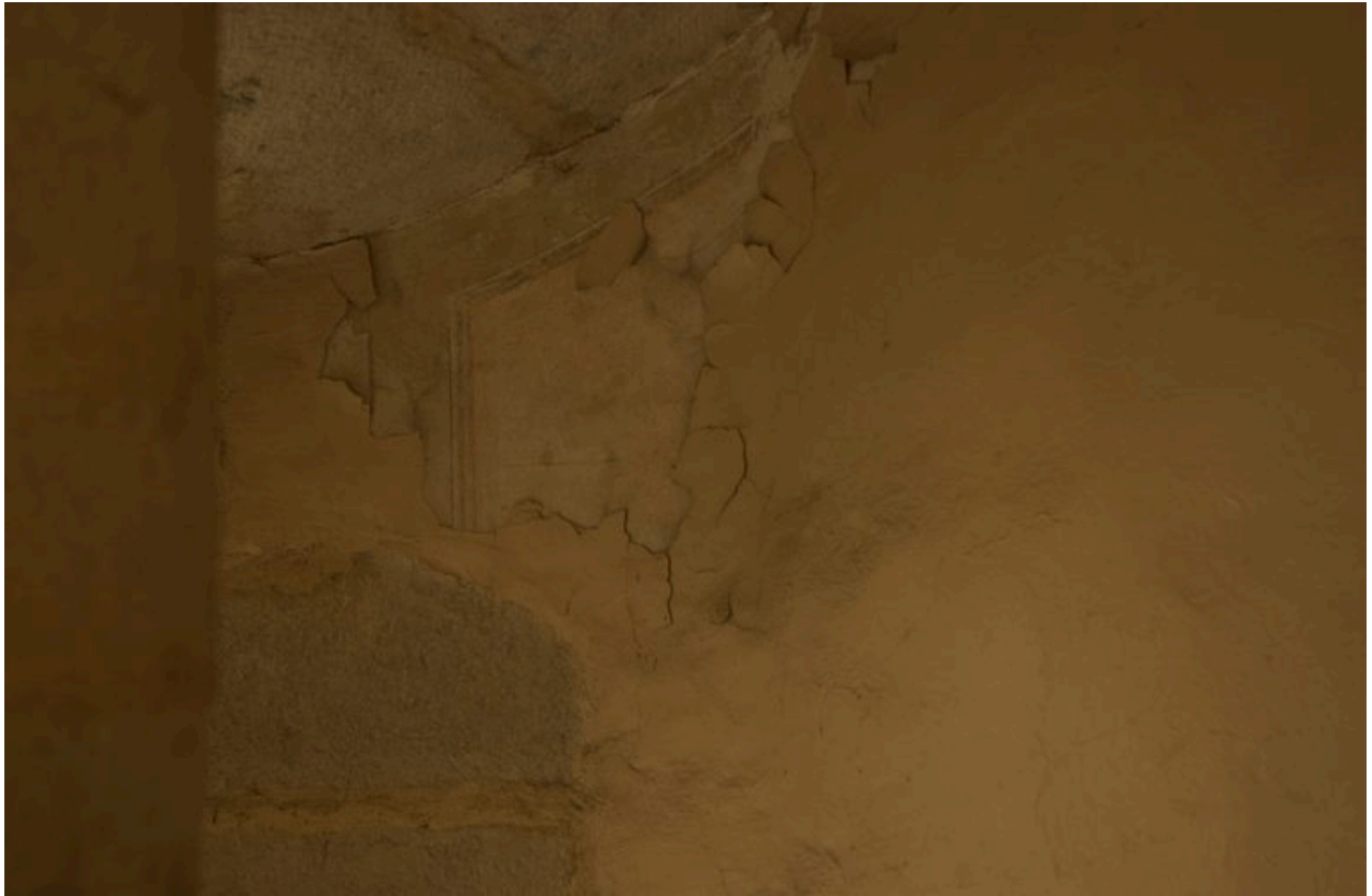
Détail de décor dans la cage d'escalier
