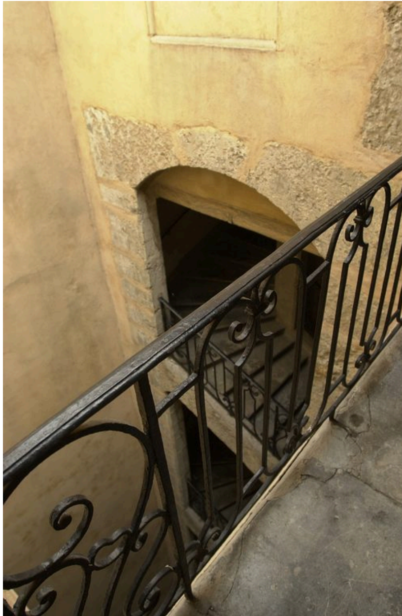
L'escalier en plongée : vue partielle
