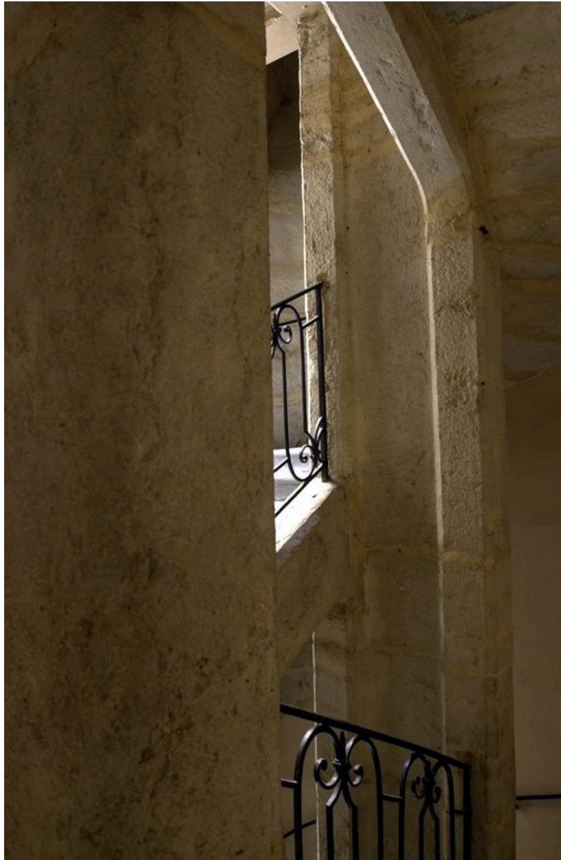
L'escalier : noyaux et garde-corps
