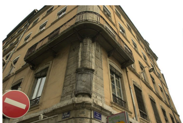
Elévation sur le quai Saint- Antoine : traitement de l'angle Phot. Véronique Belle IVR82_20076902928NUCA
