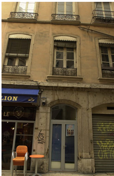
Elévation rue de la Monnaie : vue partielle Phot. Véronique Belle IVR82_20076902931NUCA
