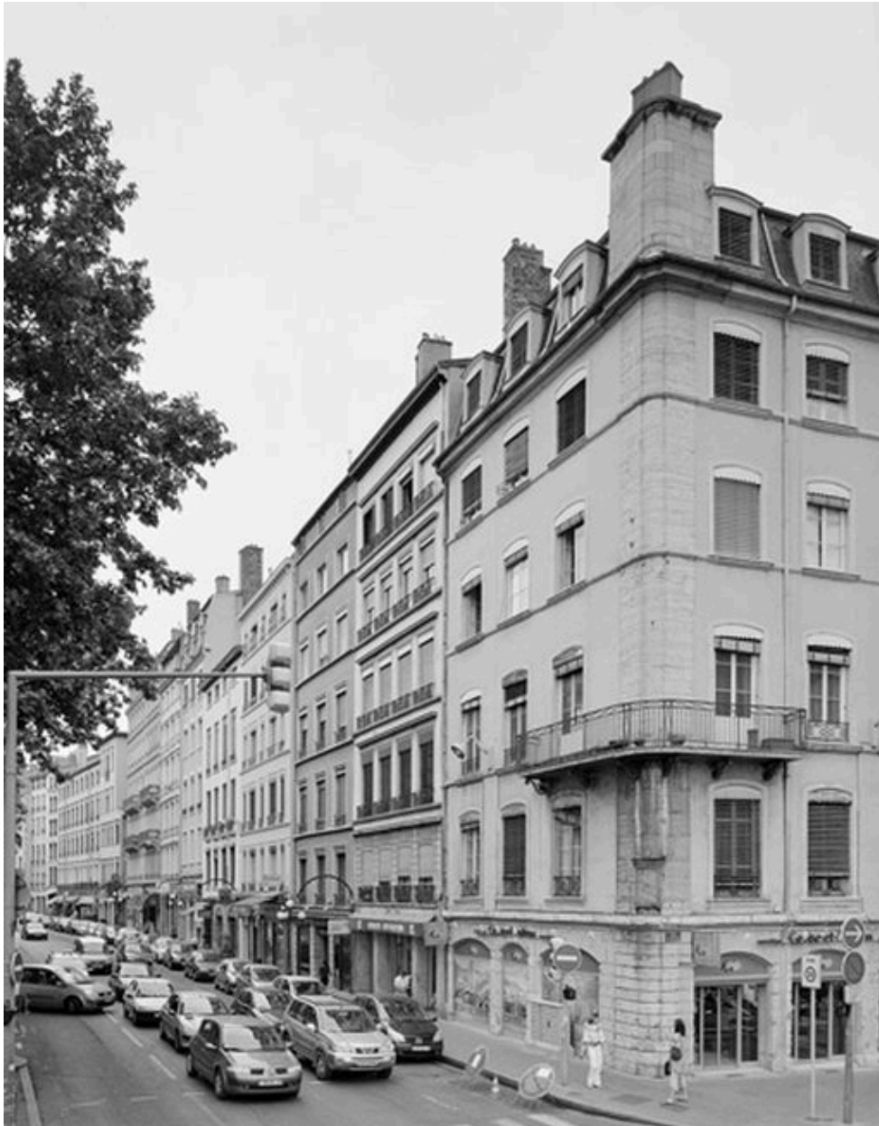
Vue de situation depuis le quai Saint-Antoine
