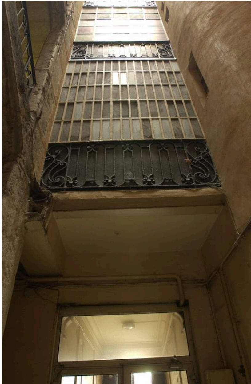
Les galeries reliant l'escalier au corps de bâtiment sur le quai
