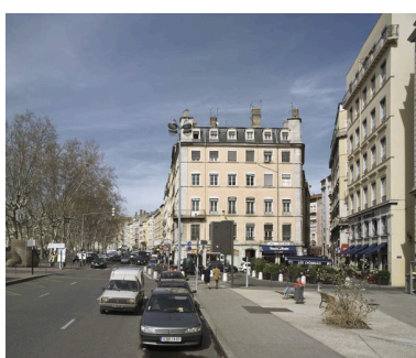
Vue de situation depuis le quai des Célestins Phot. Eric Dessert IVR82_20066900472NUCA
