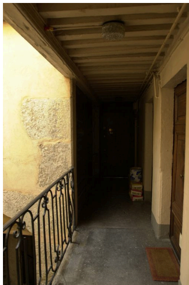
Galerie du dernier étage et porte palière Phot. Véronique Belle IVR82_20076902940NUCA
