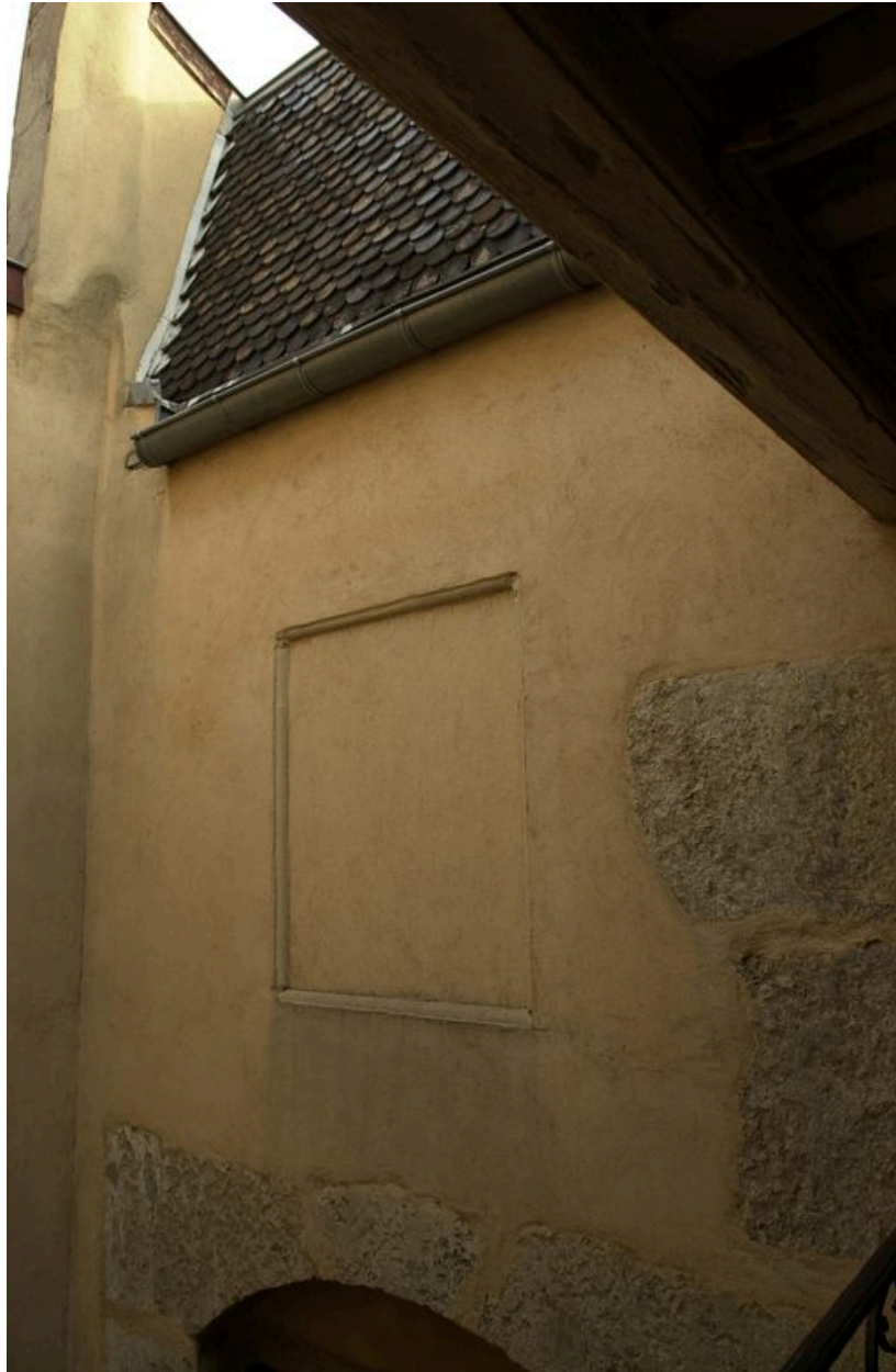
La cage d'escalier : dernier étage
