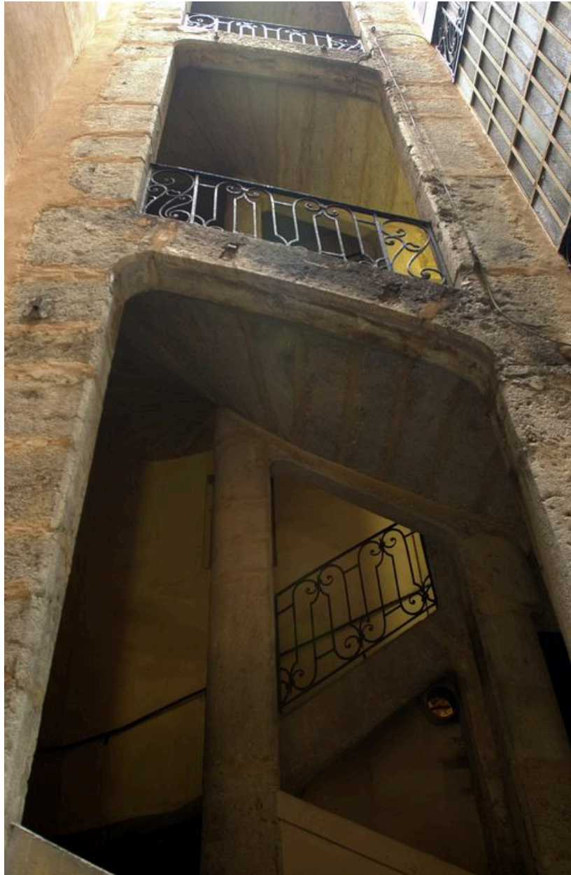
L'escalier en contre-plongée : vue partielle
