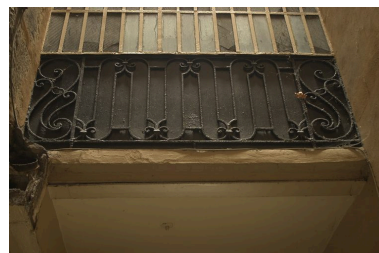
Garde-corps de la galerie du premier étage carré Phot. Véronique Belle IVR82_20076902935NUCA
