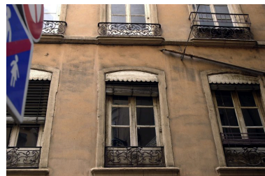
Elévation rue de la Monnaie : détail de baies Phot. Véronique Belle IVR82_20076902932NUCA
