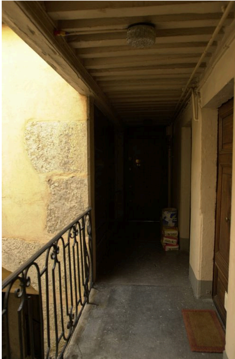
Galerie du dernier étage et porte palière
