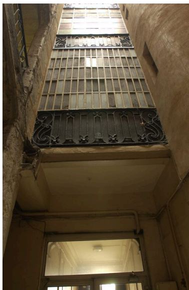
Les galeries reliant l'escalier au corps de bâtiment sur le quai Phot. Véronique Belle IVR82_20076902934NUCA
