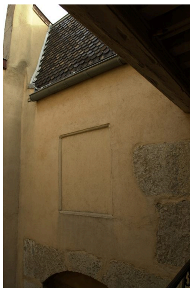
La cage d'escalier : dernier étage Phot. Véronique Belle IVR82_20076902938NUCA
