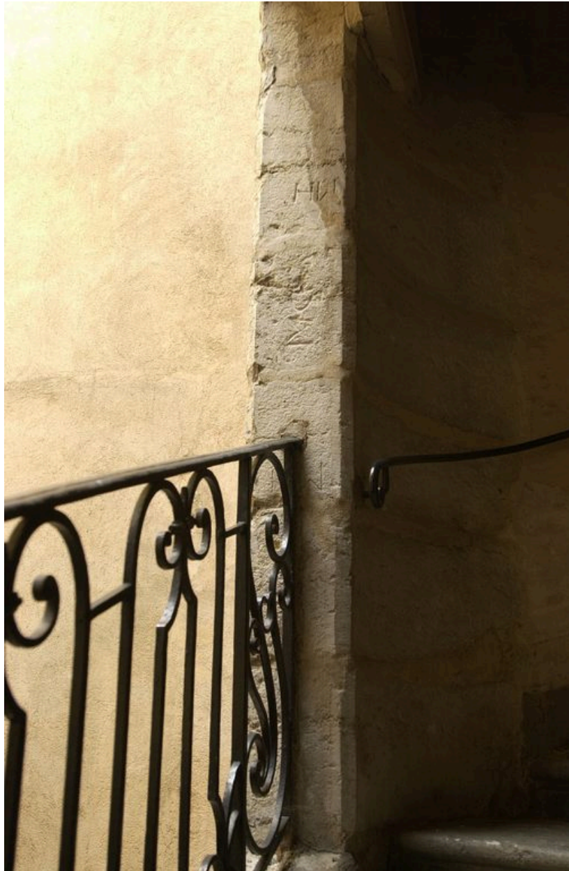
Marques de tâcherons dans l'escalier
