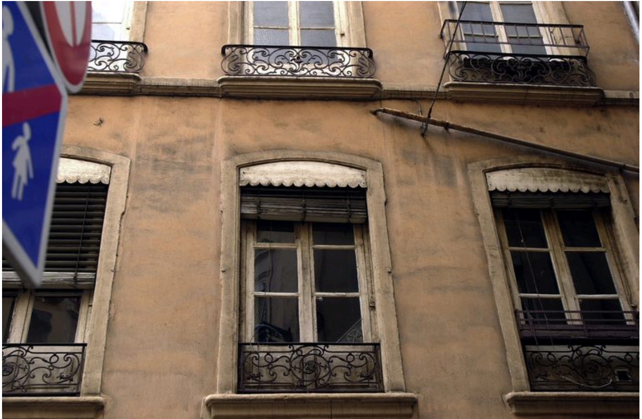
Elévation rue de la Monnaie : détail de baies
