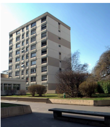
Immeuble ouest Phot. Maryannick Chalabi IVR82_20116904986NUCA
