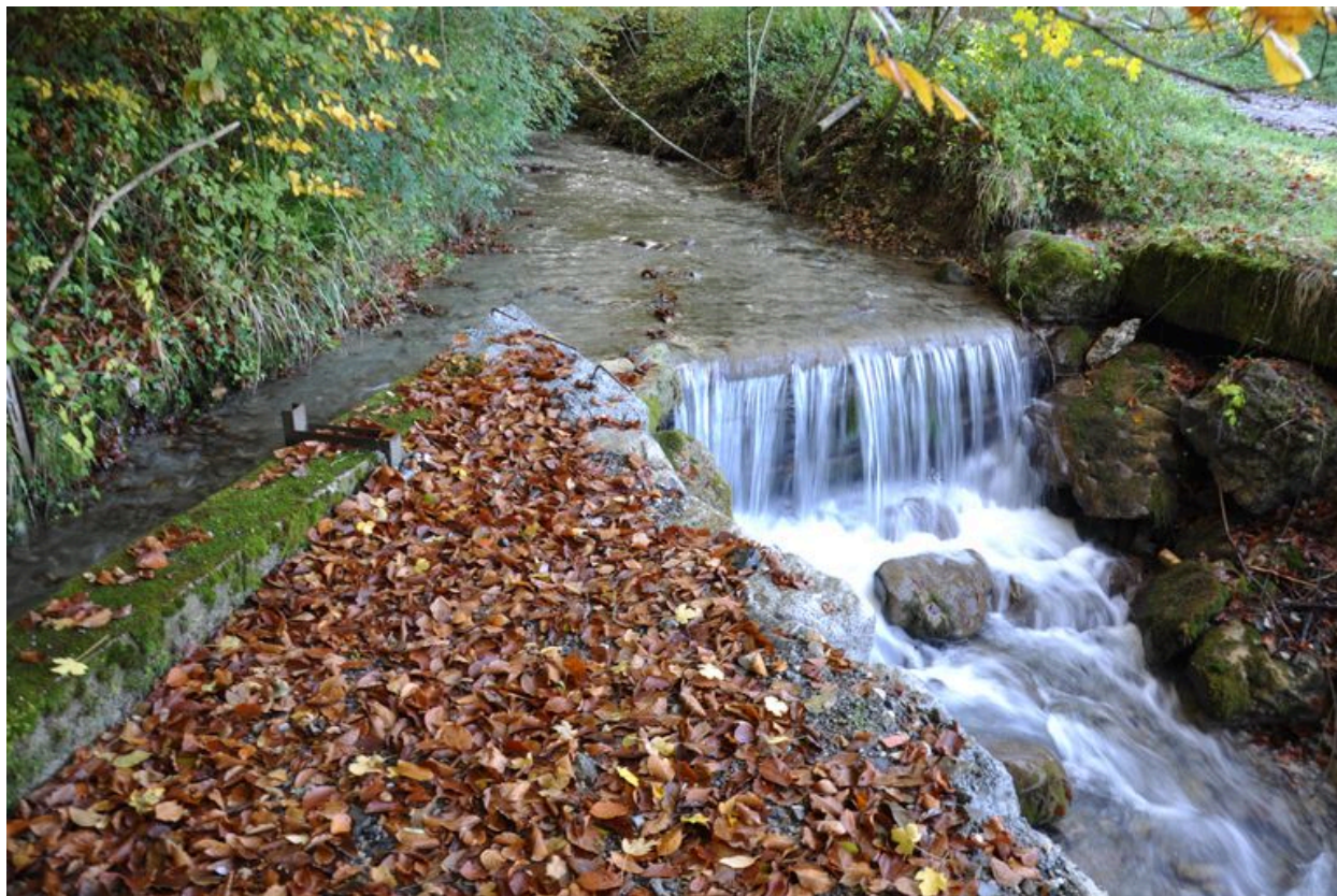
Seuil de la prise d'eau
