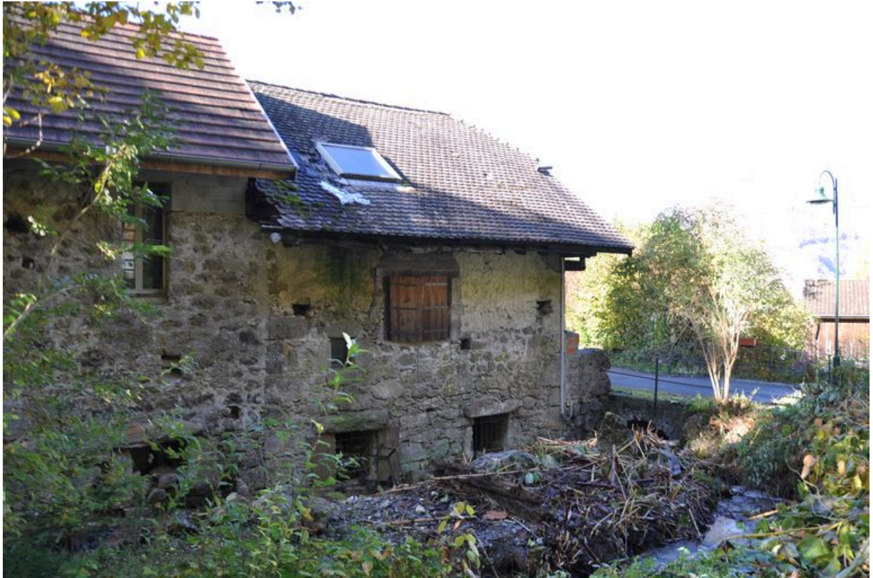
Succesion des bâtiments du moulin côté bief
