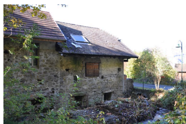
Succession des bâtiments du moulin côté bief Phot. Samir Mahfoudi, Autr. Samir Mahfoudi IVR82_20117401351NUCA
