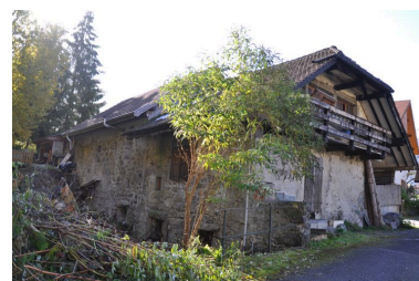
Elévation nord-est du bâtiment du moulin Phot. Samir Mahfoudi, Autr. Samir Mahfoudi IVR82_20117401352NUCA
