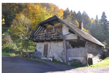
Elévation nord-ouest du bâtiment du moulin Phot. Samir Mahfoudi, Autr. Samir Mahfoudi
