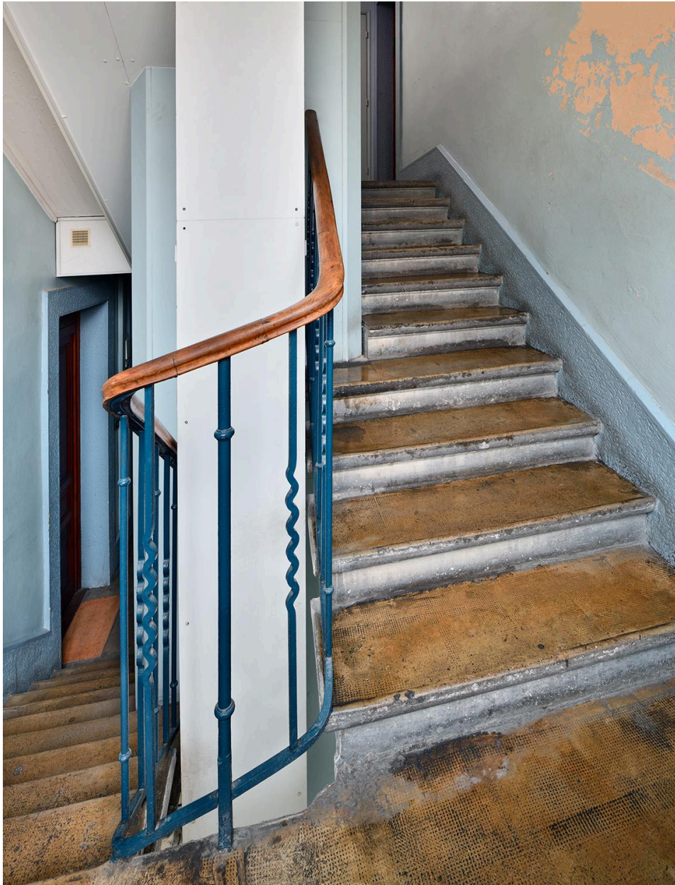
Escaliers immeuble cité jardin
