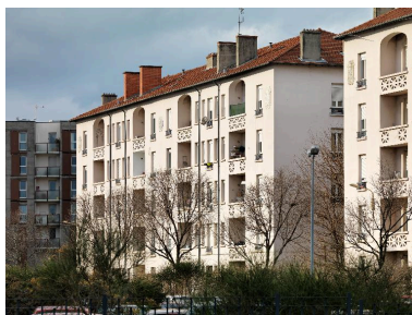
Elévations rue Benjamin-Delessert, en direction de l'avenue Jean-Jaurès Phot. Eric Dessert IVR84_20176900416NUCA
